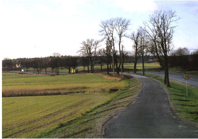
Allén, med gång- och cykelvägen i den gamla vägens läge och ny väg vid sidan om.
