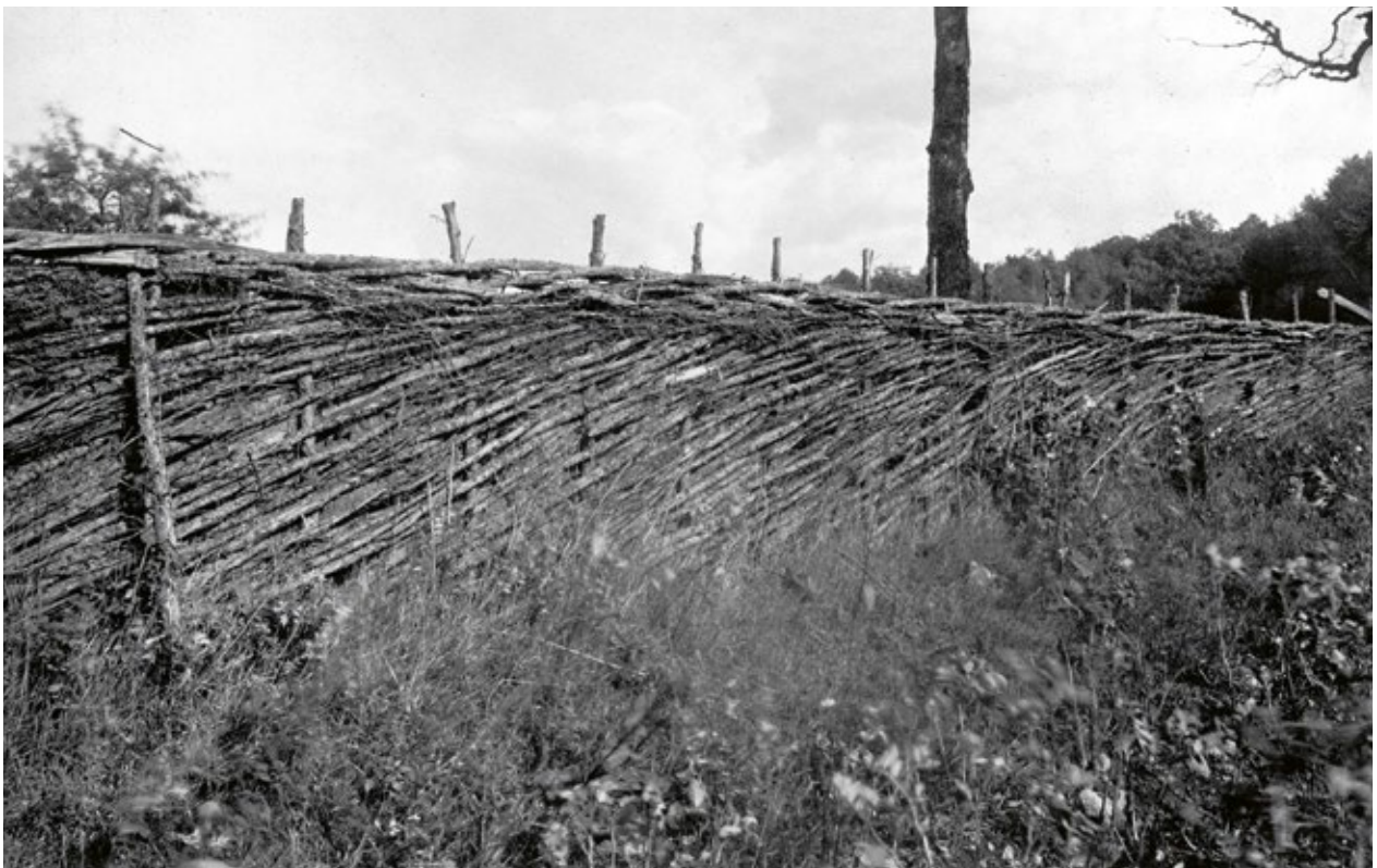
Flätgädesgård av kvistad en, flätad med svagt lutande inflätning och ett horisontellt övre plan. Sandåkra, Norra Mellby socken, 1924. Foto: Mårten Sjöbeck, Helsingborgs museums samlingsdatabas Carlotta (PD).
