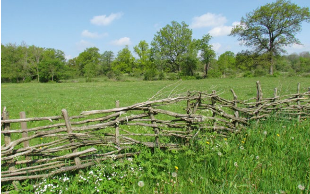
Flätgärdesgård av kvistad en, uppförd på Hörjelgården 2012. Denna horisontellt flätade gärdesgård är förmodligen den beständigaste av gårdens gärdesgårdar. Foto: Fabian Mebus/RAÄ.
