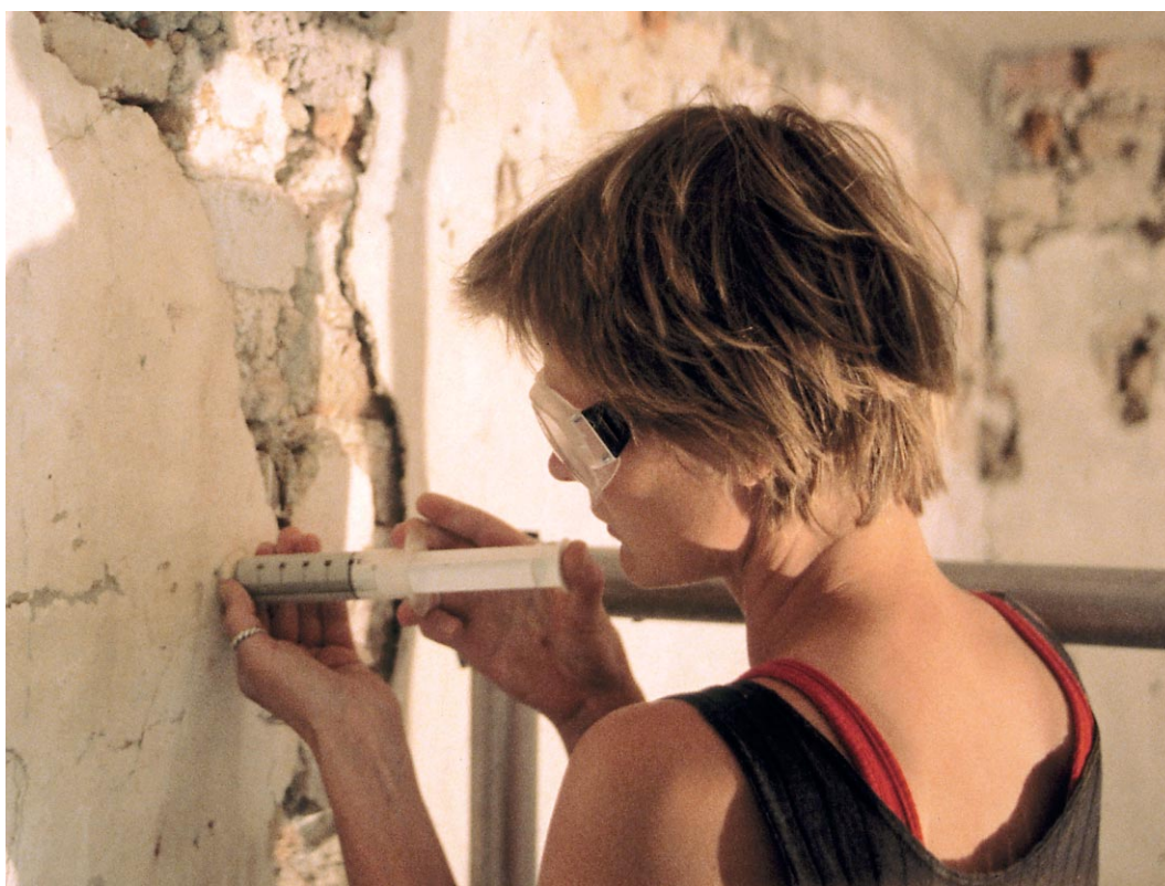
Fig. 3. Lös puts som riskerar att falla ner fästs in med hjälp av en lösning som sprutas in bakom putsen (putskonsolidering).
