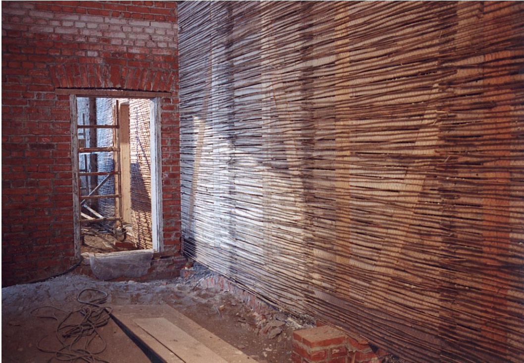
Fig. 5. Tegelvagg och trapanelvagg med vassmatta som skall putsas.
