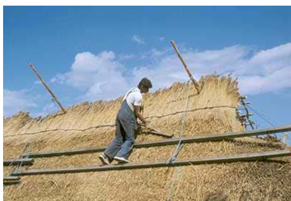
Efterbehandling av vasstak som drivs med täckeraga. Eketorps borg på Öland. Foto: EAr
