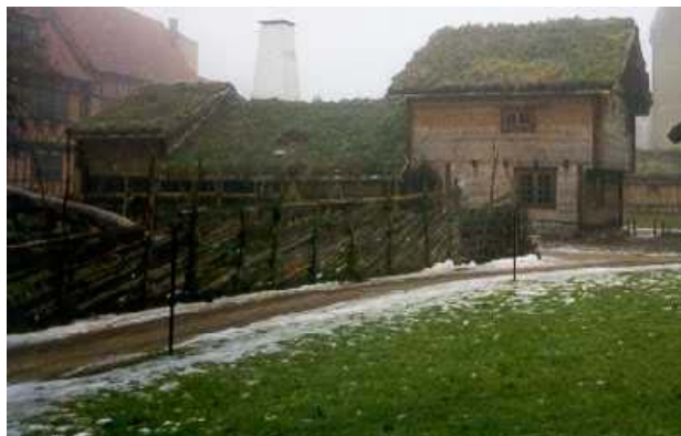
Blekingegården på kulturen i Lund, med nytt torvtak lagt 1998 enligt antikvarisk rätt metod. Foto: TFo
