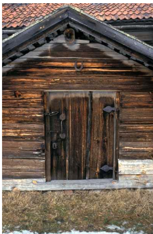
En fäbodgavel som bestrukits med trätjära får ett klassiskt och vackert uttryck. Foto: TER
