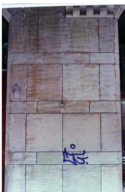
Kalksten som blästrats med JOS-bläster som partiellt avlägsnade det med tiden erhållna brunaktiga ytskiktet, patinan. Blästersvepen syns nu som ränder på ytan. Foto: HEHa
