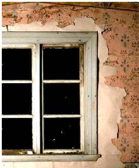
Ilagning av schablonmålade tapeter på Fröreda storegård, Järnforsen. Foto: Jönköpings läns museum
