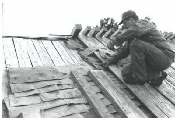
Nävertäckning med vedtäckning på 1700-talsloge. Vedtakstypen kallas ibland för knäppetak, eftersom virket knäpps ihop övernocken. Foto: Stig Nilsson
