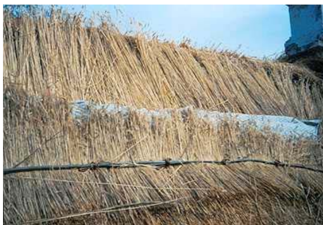
Modernt brandskydd av ett halmtak: Obrännbara mineralullsmattor kläms fast under halmen. Oktorpsgården på Skansen, Stockholm. Foto: EAr
