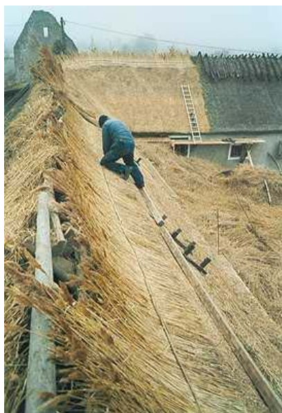
Vasstaksläggning i Borgs by på Öland. Foto: EAr
