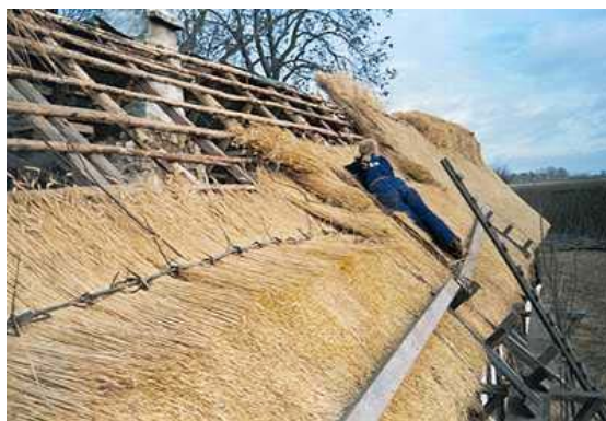
Läggning av halmtak med raft och tilling. Foto: EAr
