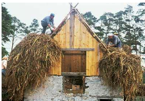
Ag läggs som ett lag arbete, agating. Här på ett fårhus, lammgift, på Fårö. Foto: EAr
