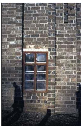
Slaggtegel medger samma arkitektoniska frihet som lertegel. Foto: TER
