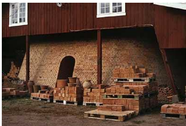
Horns tegelbruk i Västergötland är det enda bruk som ännu slår tegel för hand. Bilden visar en av ugnarna och exempel på tegelprodukter som bränts där. Foto: OAn
