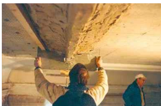
Schablondragning på underlag av stockningsbruk. På det färdigdragna underlaget kan man modellera ut den slutliga formen eller montera någon form av gipselement. Foto: ULe
