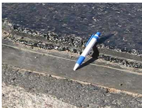
På betongytan pålimmas ett gas-utjämnande skikt av mineralfiberfilt eller liknande innan gjutasfalten påförs. Foto: TEr
