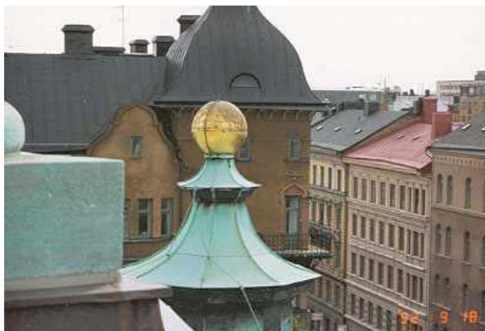
Kopparslaget torntak med förgylld koppar-kula på Gustav Vasa kyrka i Stockholm. Ärgig kolonnbas till vänster, se Vård och underhåll. Foto: MTö
