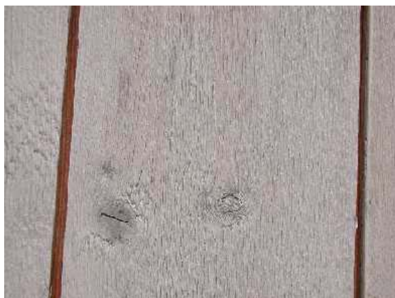
Med tiden mörknar den ljusa slamfärgen fläckvis på kvistar och andra ojämnheter. Foto: KKLy
