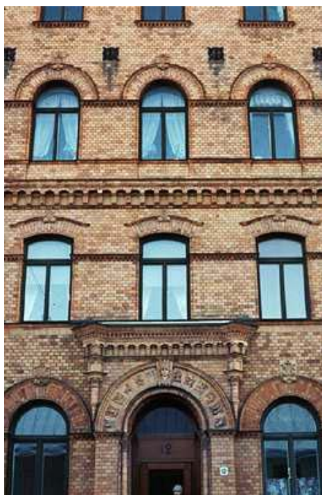
Tegelfasad från 1890 som visar fasadteglets användning. Bakom den dekorativa terrakottan och det så kallade förbländerteglets koppförband finns ett bärande murverk av stortegel. Foto: OAn
