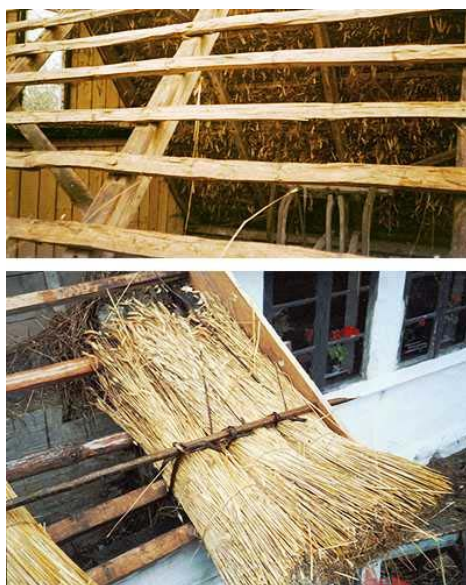
Överst en sydsvensk typ av läktning av undertak för halmtak. Därunder tre halmkärvar som kläms mellan läkt och raft. Foto: EAr
