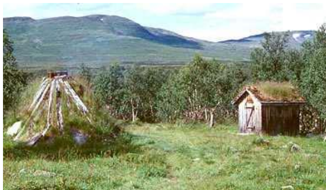
Dessa byggnader, en torvkåta och ett förråd, på sommarvisten Bartjan (Kroktjärnsvallen) i Tåssåsens sameby kan representera nordsvensk torvtaksteknik. Foto: Kjell-Åke Aronsson
