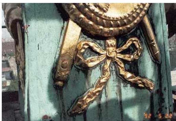
Ärgad kopparplåt och förgylld koppar på Riddarhusets tak i Stockholm. Foto: MTö
