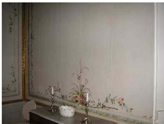
Sturehovs slott 1780-tal. Denna linoljemålade linneväv har sytts samman utefter våderns kanter och monterats på en stomme av glesa bräder, eventuellt med mellanlägg av ett styvare tyg. Därefter har den dekormålats. Vådbredd ca en aln, 60 cm. Tapeten restaurerades på 1950-talet. Foto: TEr
