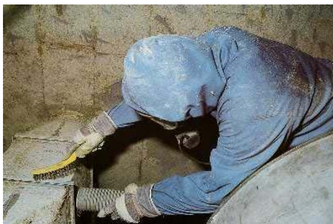
Asbestsanering med stålbeste och utsug samt rejäl skyddsutrustning. Foto: NHa
