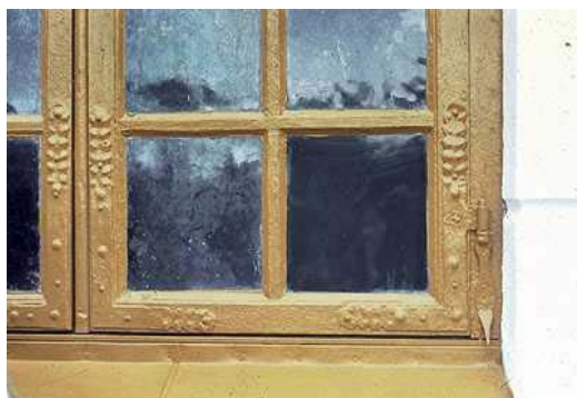
Cylinderblåst glas i träbåge med kittfals. Drottningholms slott, Stockholm. Foto: RHe
