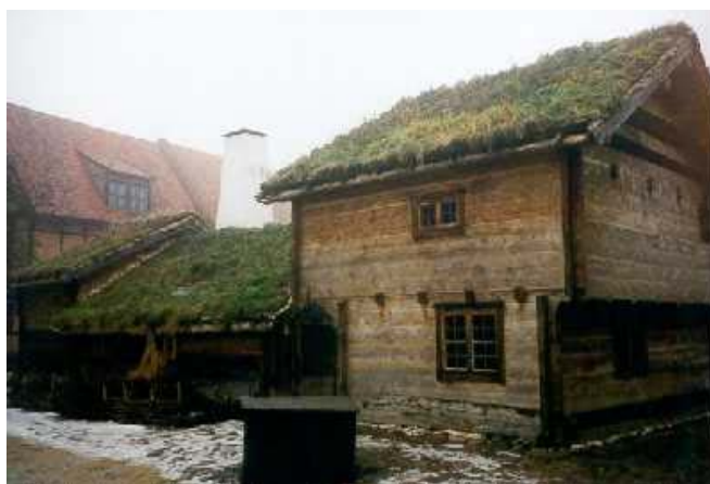
Blekingegården på Kulturen i Lund, som fick ett nytt tak 1998, är ett bra exempel på sydsvensk torvtaksteknik. Foto: TFo
