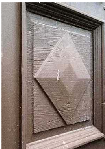
Sandblästring etsar träets vårved och höstved olika hårt och lämnar efter sig en yta som är varken historiskt representativ eller lämplig som underlag för linoljefärg. Foto: KKLy
