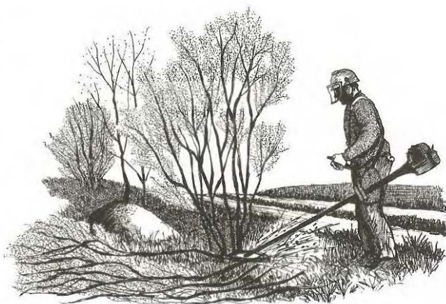
Røj buskar och sly i vägrenarna och mittsträngen.
