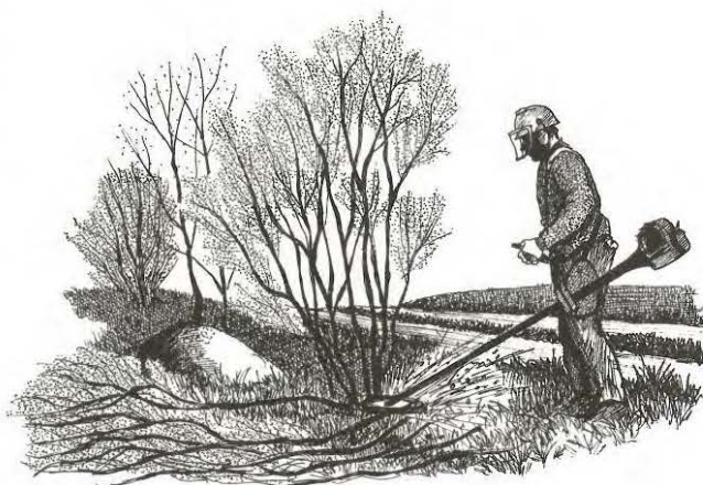
Röj buskar och sly i vägrenarna och mittsträngen.
