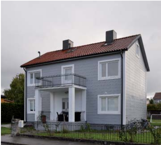
Målat eternithus. Om man vill byta färg på sitt eternithus kan man använda sig av fasadfärg för KC-puts eller betong. Foto: Helen Simonsson, Riksantikvarieämbetet.
