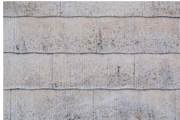
Närbild på omålad Sidiplatta som imiterar trä och tillverkades i formatet 400 x 200 mm. Foto: Helen Simonsson, Riksantikvarieämbetet.
