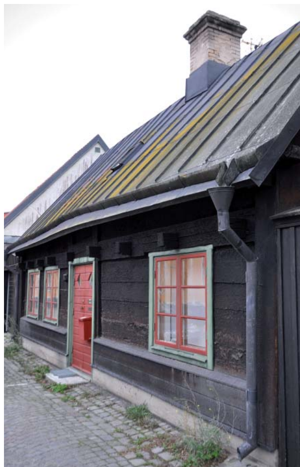
Vinkeln på stånd- eller fotrännan, som sitter på taket, fördelar vattnet och ger fall ner till de bägge stuprören. Ofta räknar man med att ett stuprör klarar en huslängd på cirka tio meter. Stuprören har ofta varit bemålade med samma färg som plåttaket.
