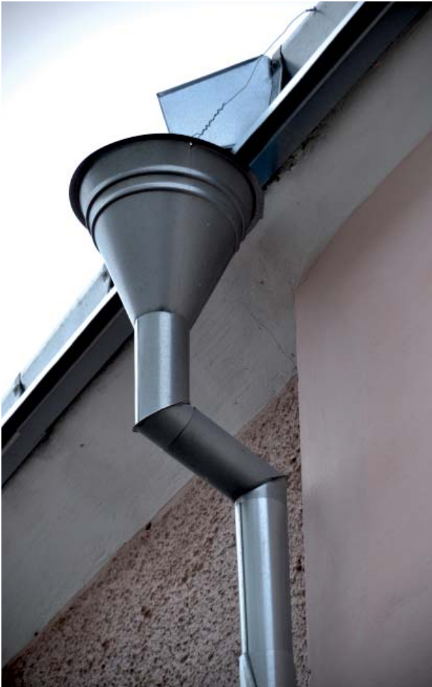
Stuprör av äldre typ med skarpa krökar och profilerad, konformad kupa. Foto: Helen Simonsson, Riksantikvarieämbetet.
