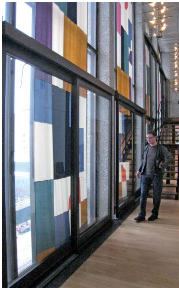
Alf Munthes gardin i Södertälje tingsrätt förstördes av flamskyddsbehandling. En nytillverkad kopia hänger där idag, ej flamskyddad. Efter ombyggnaden skyddas den av glas.
