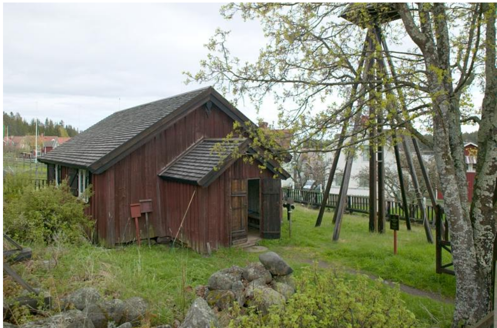
Ulöv gamla kapell i Ångermanland är en av de kyrkor som ligger i det område som kommer att få avsevärt större nederbörds mängder. Översyn av förutsättningarna på plats och ökat underhåll kommer sannolikt att behövas. Foto: Bengt A Lundberg.
