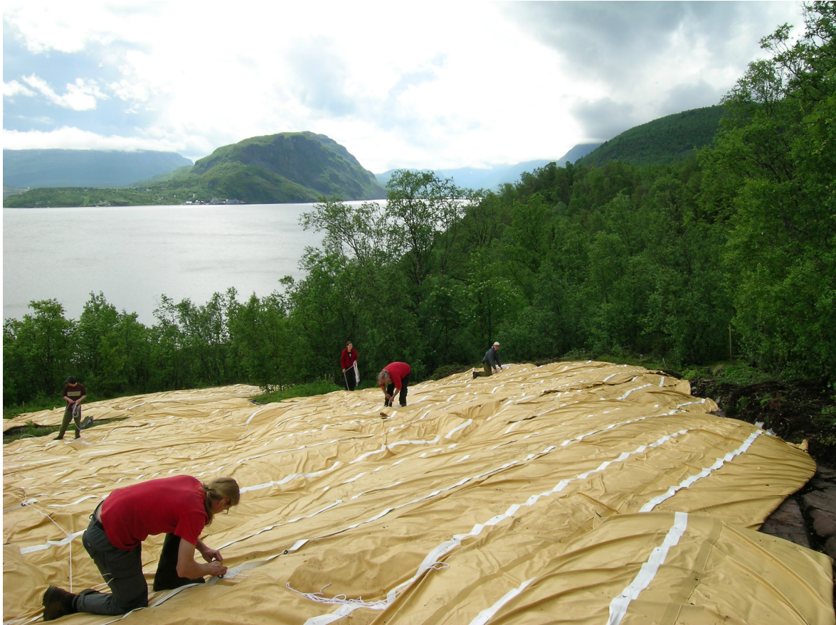
Matter med Glava legges for å isolere mot frostsprengning. Foto: Alta Museum (CC BY-NC-SA).
