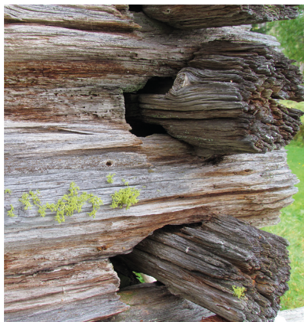
UV-ljus och värme, i synnerhet vid fuktexponering, gör att obehandlat trä bryts ner snabbare åt solsidan än skuggsidan. Foto: Fabian Mebus/RAÄ.
