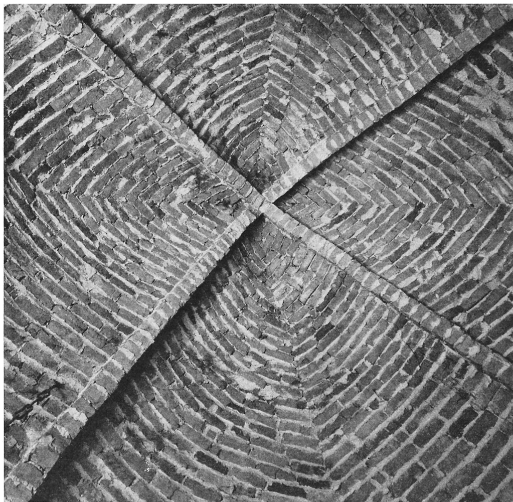
Fig. 224. Valv i rummet ovanför Silverkammaren. Bilden visar tydligt tegelförbandet i ett \frac{1}{2} -stensvalv, slaget på stick. Foto S. Hallgren 1963.
