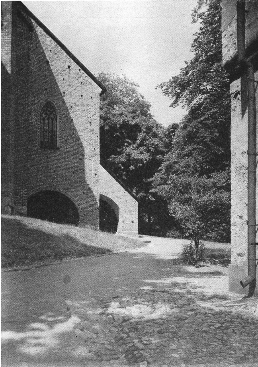
Fig. 258. Övre sakristians östra fasad. Nära dess norra hörn synes den igenmurade dörröppning, som fört ut till en täckt förbindelsegång till biskopspalatset, synligt längst t. h. på bilden. Jfr fig. 261. Foto N. Åzelius 1933.
