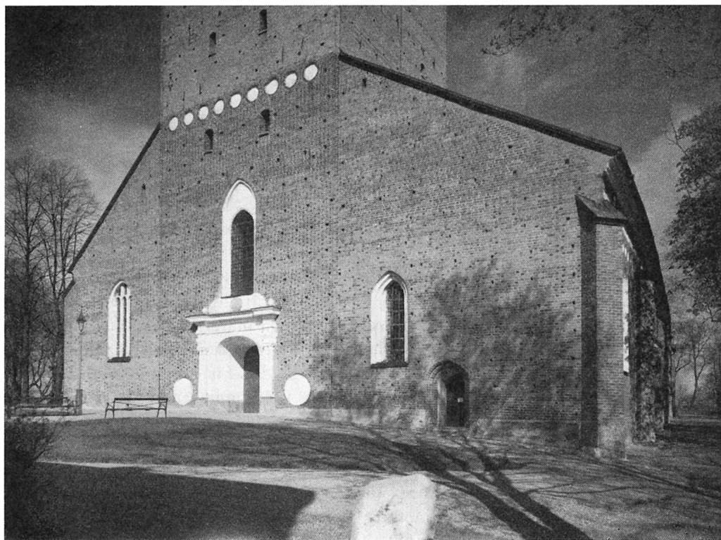
Fig. 247. Kyrkans västfasad, nedre delen, sedd från sydväst. Foto Iwar Anderson 1942. Unterer Teil der W Fassade der Kirche von SW. Lower part of W front of church, from SW.
