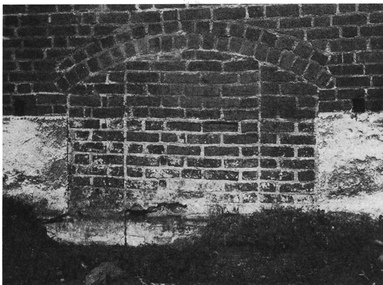
Fig. 209. Igenmurad öppning i Högkorets sydmur. Under korets uppförande använd såsom arbetsport. Foto E. Bohrn 1942.
