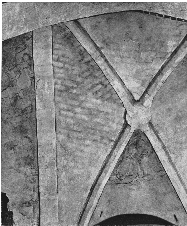
Fig. 216. Högkorets norra sidoskepp, valv NN2. Bilden visar de olika kappornas tegelförband. Foto S. Hallgren 1963.
