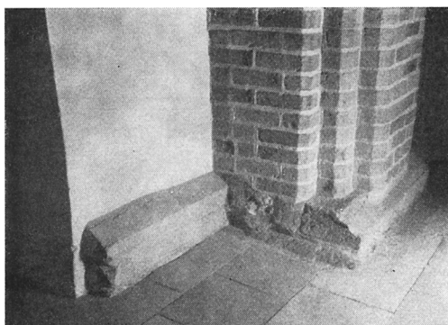
Fig. 212. Högkorets pelare 10 C med bas av huggen kalksten. T v. sockelstycke på Kärnkirkans östfasad. Foto Iwar Anderson 1945.
