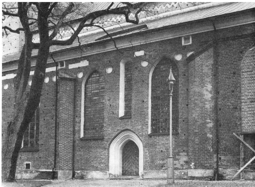
Fig. 235. Sydfasaden med Södra vapenhusets yttermur. Foto Iwar Anderson 1945. Südfassade. Aussenmauer der S Vorhalle. S front of S porch.
