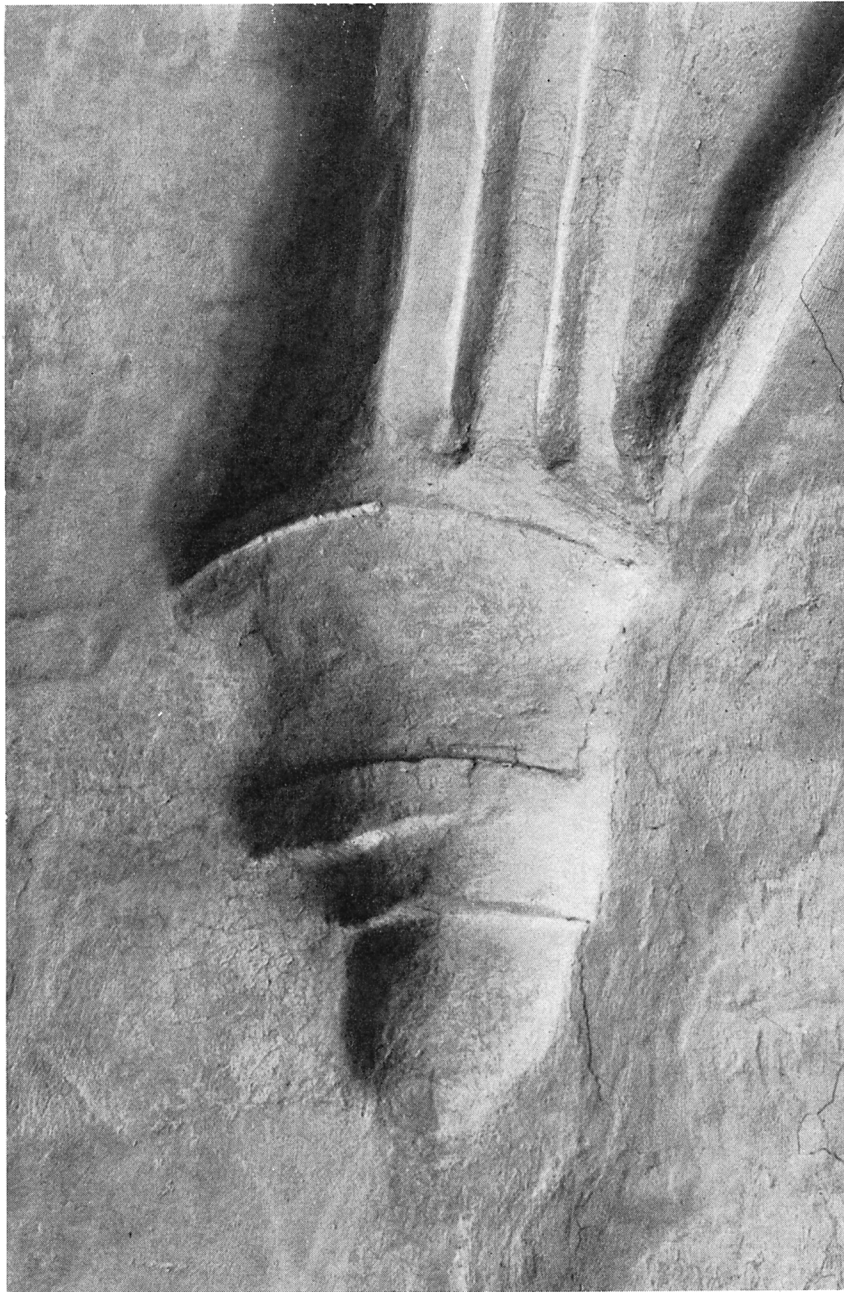
Fig. 184. Valvkonsol i Tynnelsökorets nordöstra hörn. Foto S. Hallgren 1963. Gewölbekonsol in der NO Ecke der Tynnelsö-Kapelle. Vaulting corbel in NE corner of Tynnelsö Chapel.
