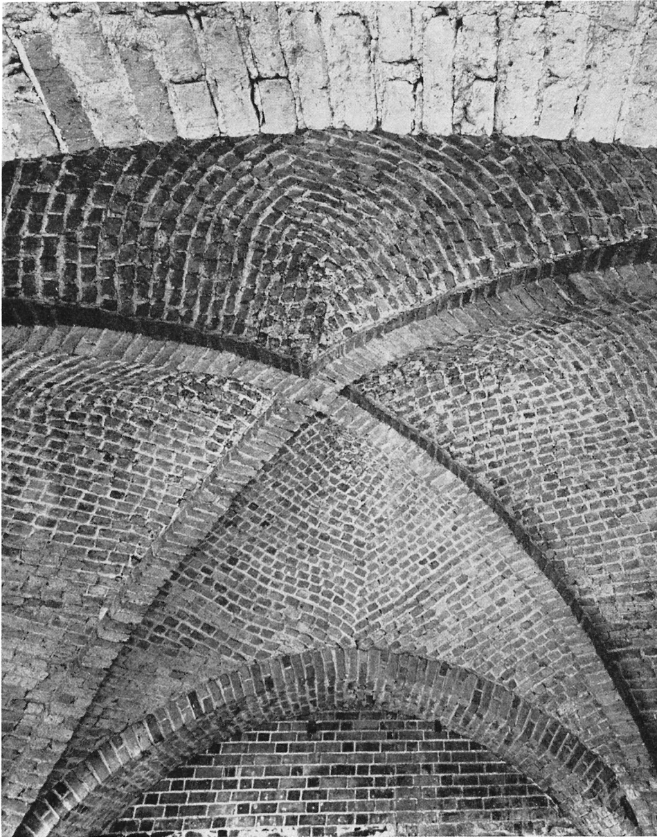
Fig. 257 Valvet under Övre sakristian. Bilden visar tegelförbanden i ett 1-stens kryssvalv, slaget på stich. Foto S. Hallgren 1963.
