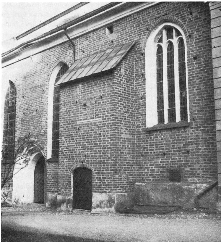
Fig. 242. Predikotornet. Taleöppningen (nu igenmurad) synes ovan det smala ljusa bottenstycket av kalksten mitt på tornets nordsida. Foto P. O. Westlund 1937.
