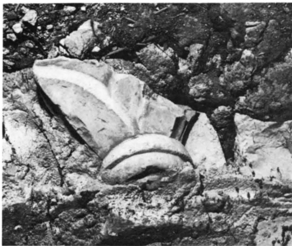
Fig 64. Detalj av muren ovanför gördelbågen C 3–C 4 med stenskröt från långhusets äldre del. Foto E Niklasson 1962. ÖLM.
