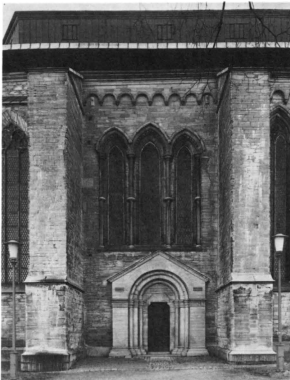
Fig 116. Tvärhusets norra fasad. Foto SvK 1986.
