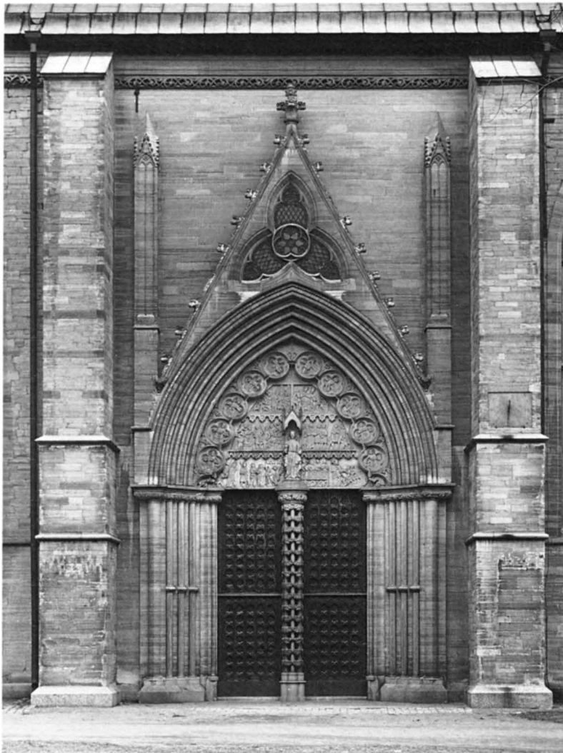
Fig 130. Långhusets sydportal. Foto SvK 1986.
