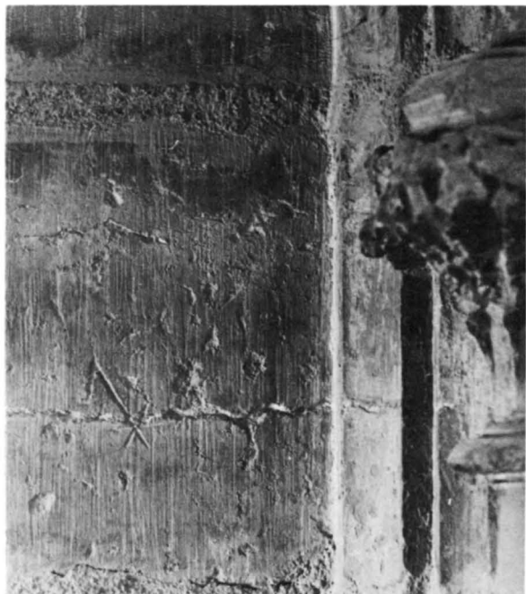
Fig 107. Pelarbasen D 11 med stenhuggarmärke C 11. Av bilden framgår även periodernas olika stenbehandling. Jfr fig 106. Foto SvK 1986.
