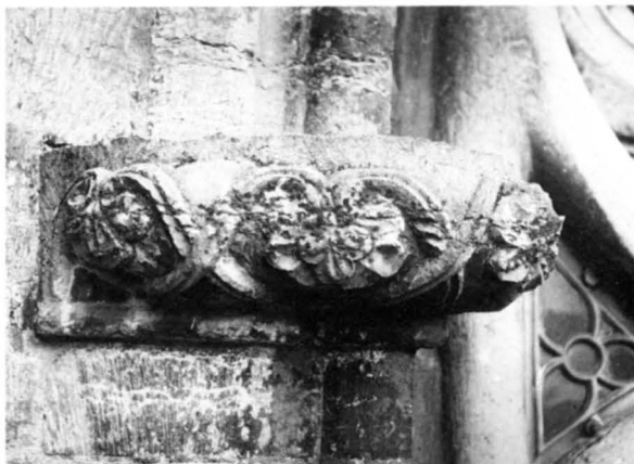
Fig 159. Kapitäl med stiliserad bladdekor. Ingår i utvärdig omfattning till fönster N3. Jfr fig 67. Foto ATA.
