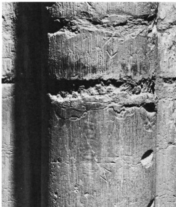
Fig 106. Detalj av pelare A 11 med stenhuggarmärkena B 25 och C 29. Av bilden framgår även periodernas olika stenbehandling. Jfr fig 78. Foto SvK 1986.
