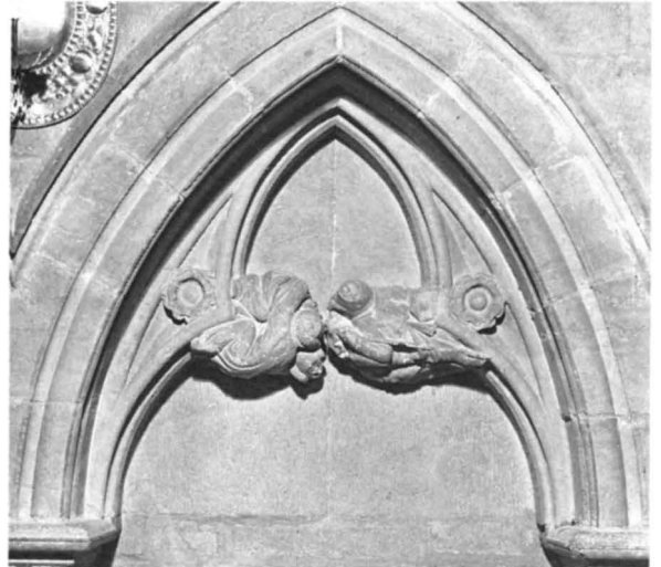
Fig 182. Detalj av bågställning nr N7. Foto SvK 1986.
