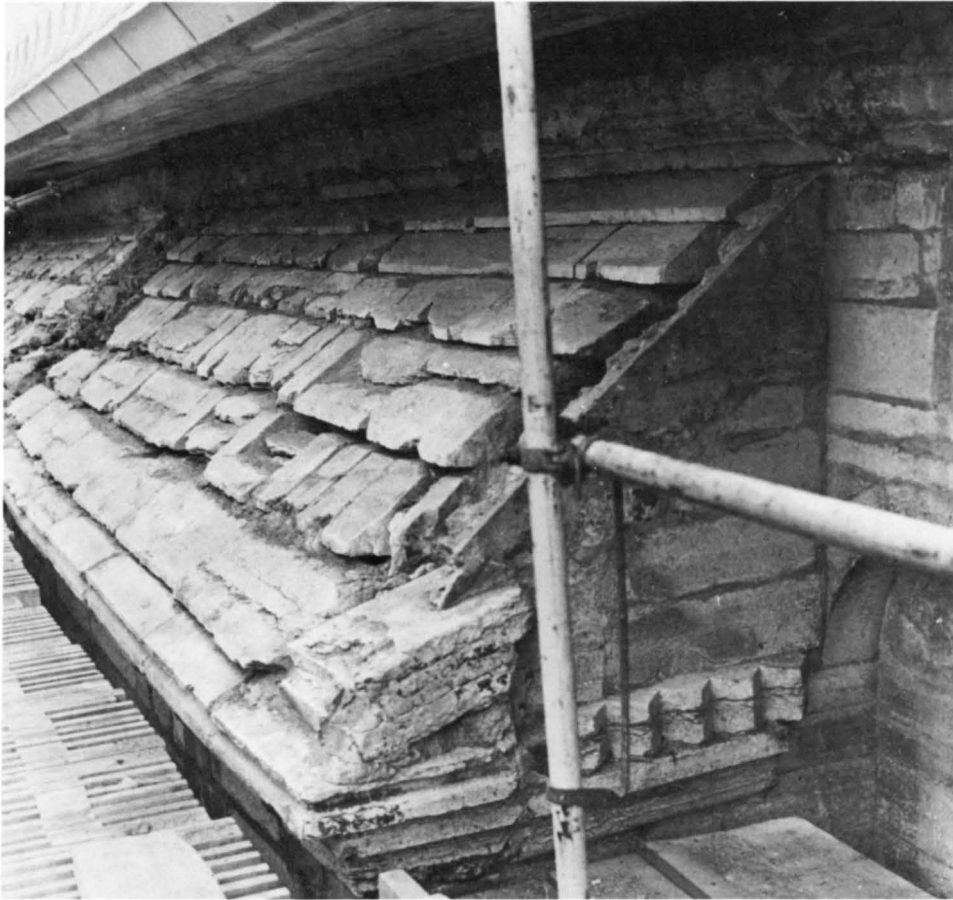
Fig 38. Bevarad medeltida taktäckning av kalksten på tvärhusets norra del. Jfr fig 37. Foto ÖLM 1966.
