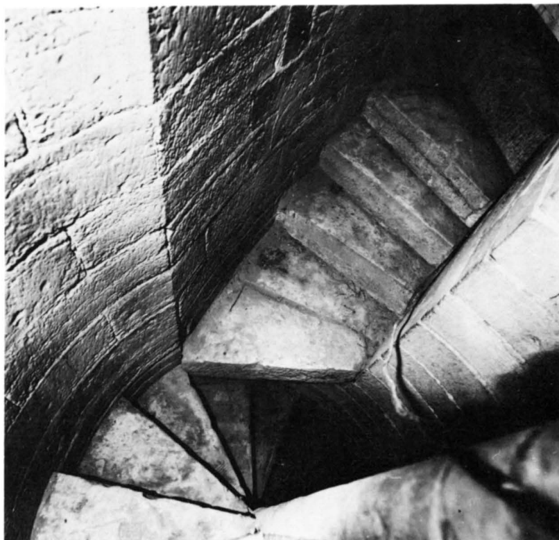
Fig 51. Murtrappa ledande till läktare och vind i södra sidoskeppet. Jfr fig 50. Foto E Niklasson 1960. ÖLM.
