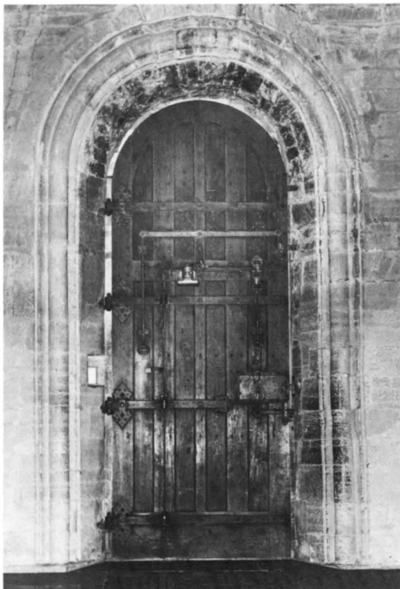
Fig 125. Nordportalens invändiga omfattning. Foto K Hallin 1986.
