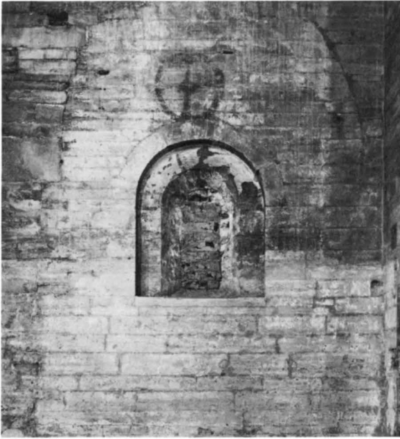
Fig 44. Igensatt ursprungligt fönster i sydväggen i travé 9 samt spår av rivet valv. Foto Gillberg, Linköping 1930. ATA.
