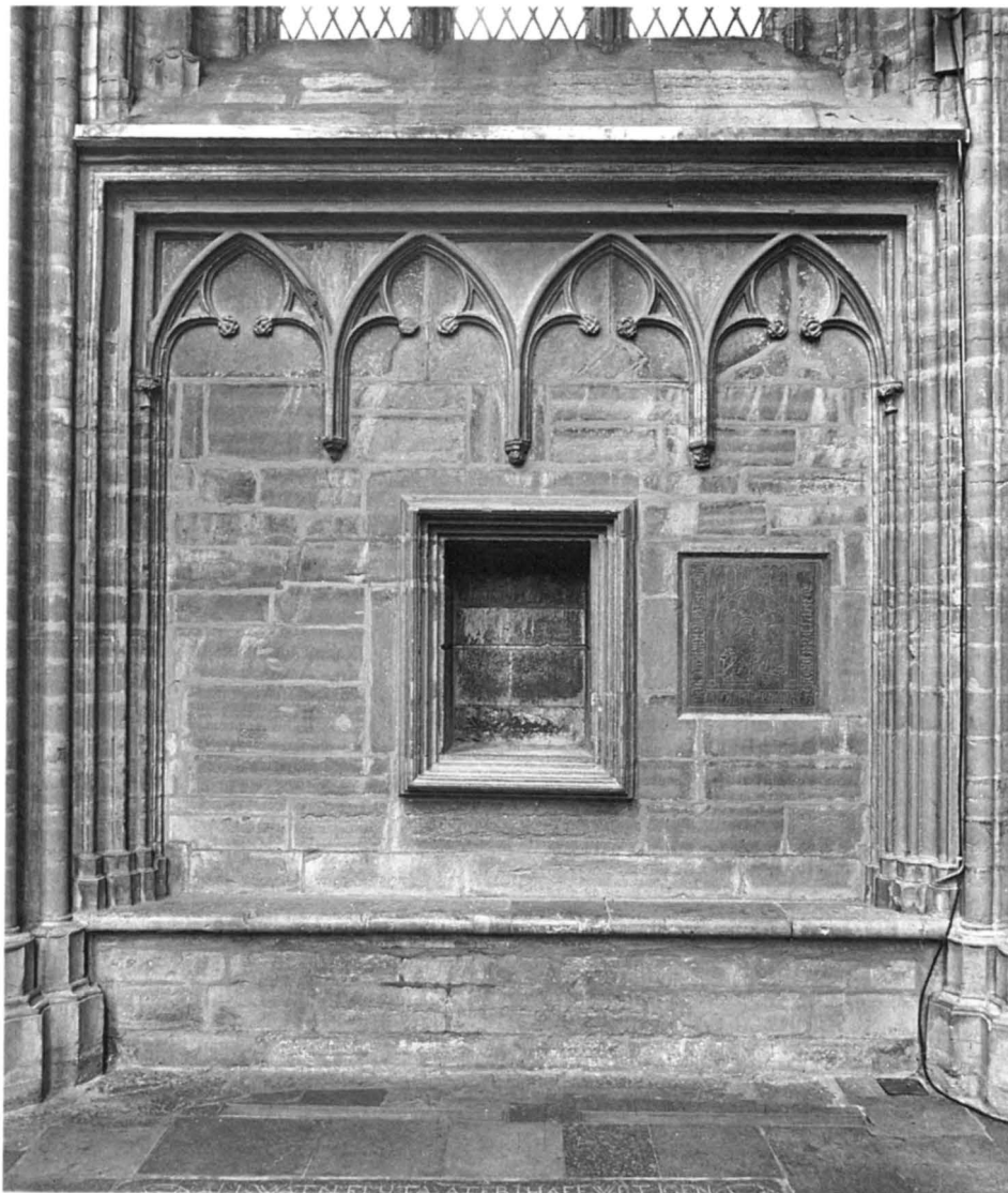
Fig 222. Östra kapellet. Detalj av väggfält D17–D18. Foto SvK 1980.
