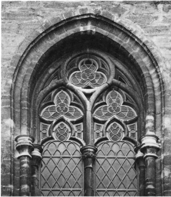
Fig 65. Fönster N 1. Foto SvK 1986.
