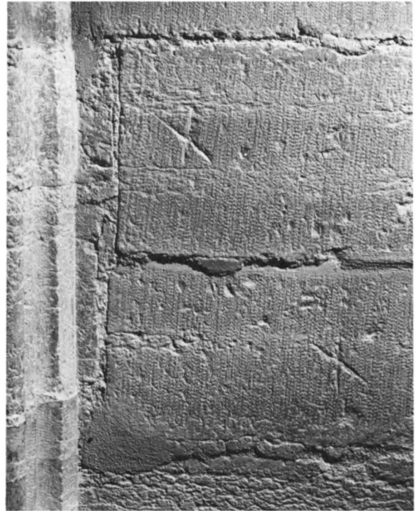
Fig 97. Detalj visande den västra långhusväggen enkla stenhuggarmärken i blindarkaden, norra delen. Foto SvK 1986.
