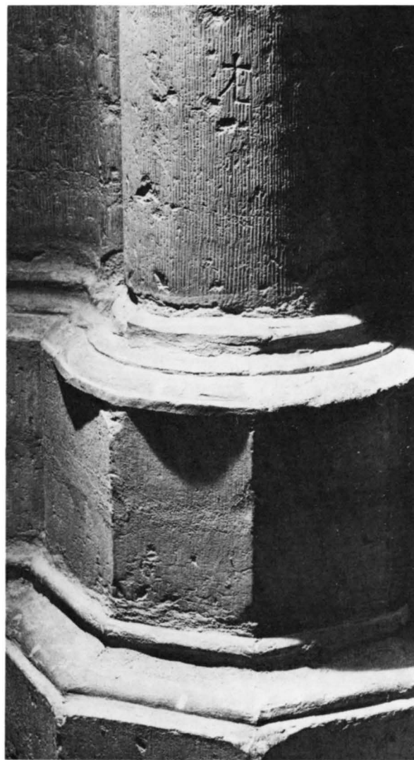
Fig 107. Pelarbasen D 11 med stenhuggarmärke C 11. Av bilden framgår även periodernas olika stenbehandling. Jfr fig 106. Foto SvK 1986.
