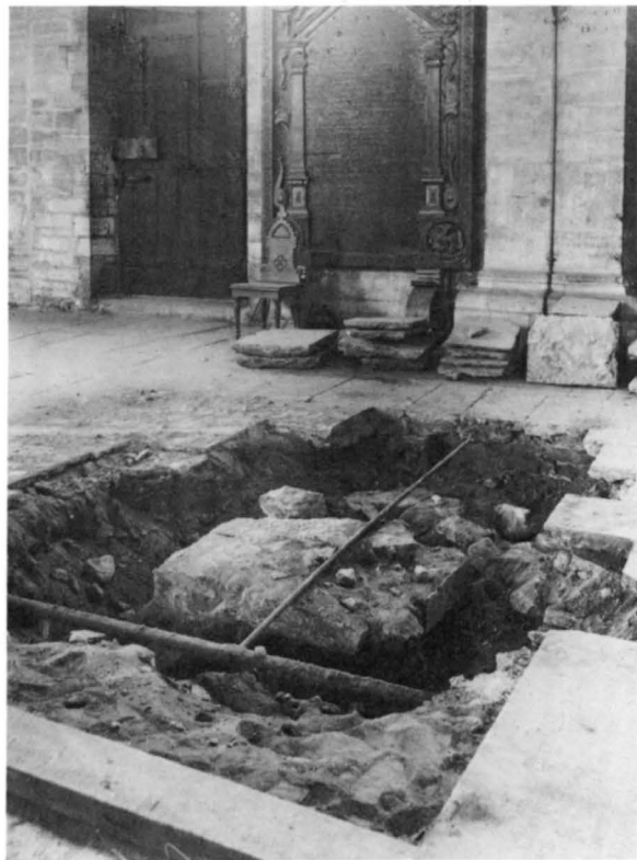
Fig 49. Pelargrund i södra sidoskeppet mellan C 8 och D 8. Frilagd vid utgrävningen 1915. Foto 1915. ATA.
