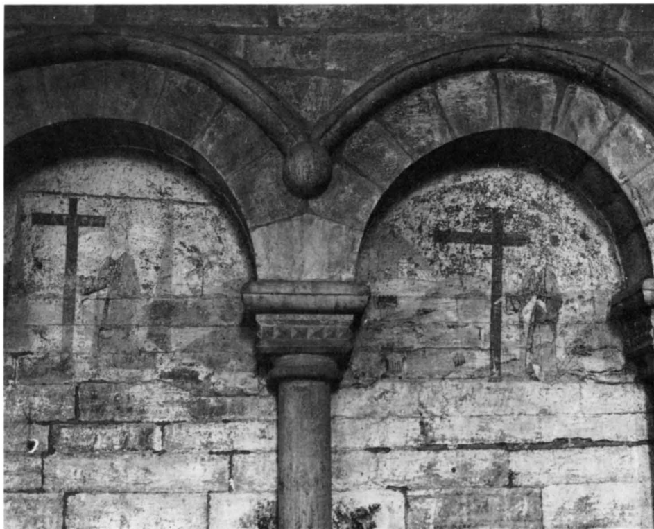
Fig 332. Detalj av södra blindarkaden med rester av senmedeltida väggmålningar. Målningarna har omfattat tre scener ur Heliga korsets legend. Jfr fig 333–335. Foto ATA.
