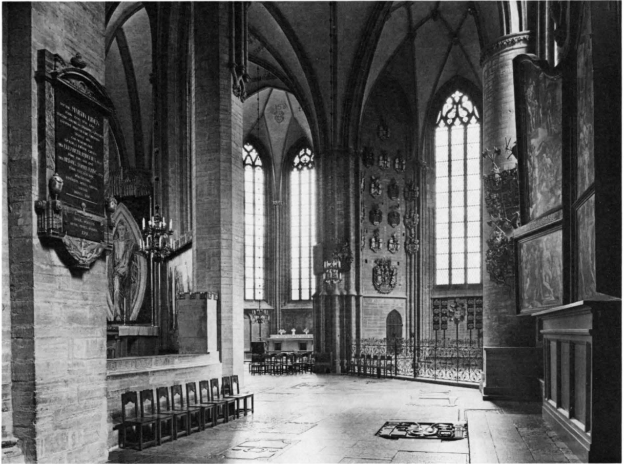
Fig 16. Södra delen av koromgången mot öster. Foto SvK 1977.
