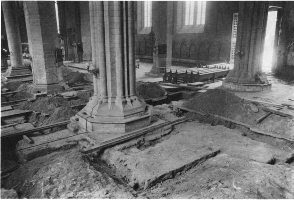
Fig. 406. Grundmurarna till kyrkans västparti. Frilagda vid utgrävningen 1915-16. Foto ATA.
