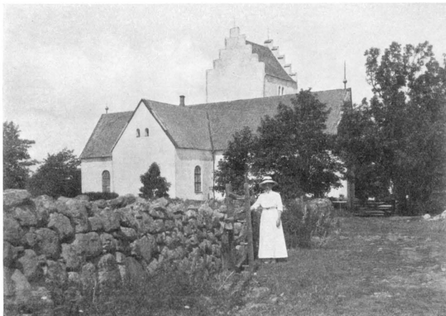
Fig. 11. Kristianopel. Exteriör av kyrkan från söder. — Foto William Anderson 1913. Die Kirche von Süden. — The church from the south.
