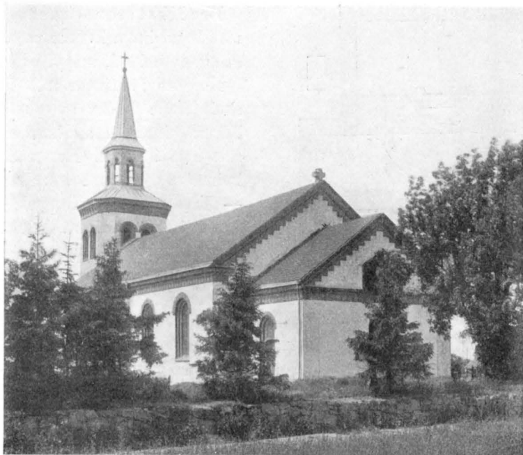
Fig. 100. Torhamns nya kyrka. Exteriör från sydost. Foto W. Anderson 1913.
