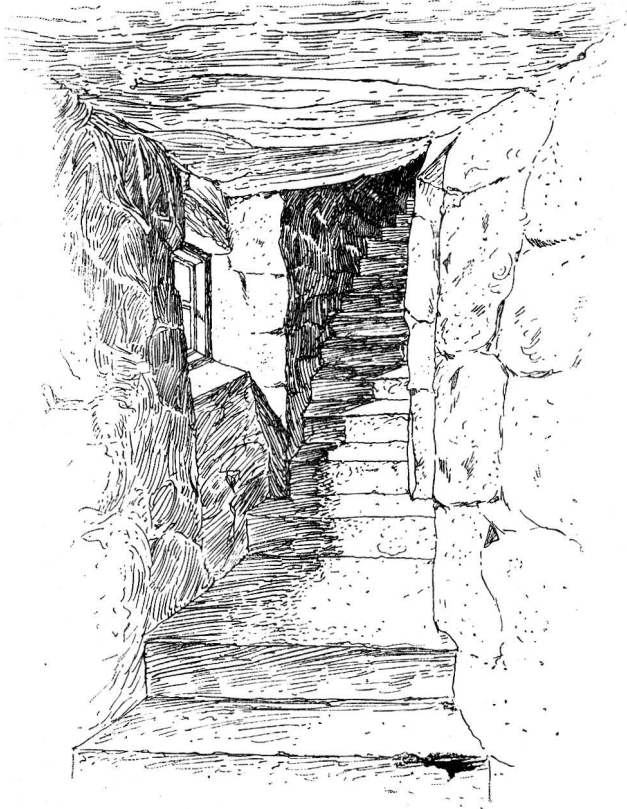
Fig. 212. Solna kyrka. Trappan i rundhusmuren. Teckning i A. T. A. Treppe in Kirchenmauer.
