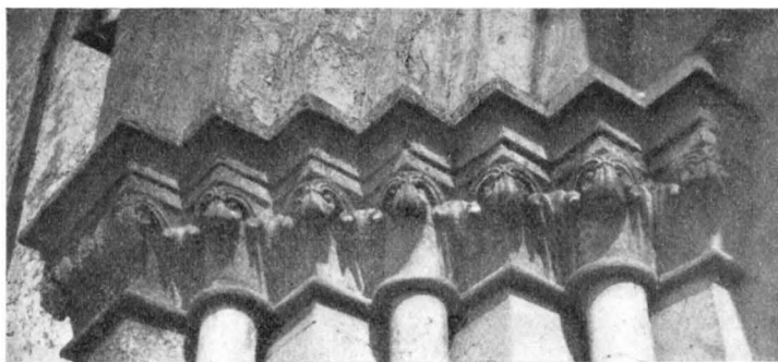
Fig. 558. Barlingbo kyrka. Sydportalen östra kapitälrad. Die östliche Kapitälreihe des Südportals.
