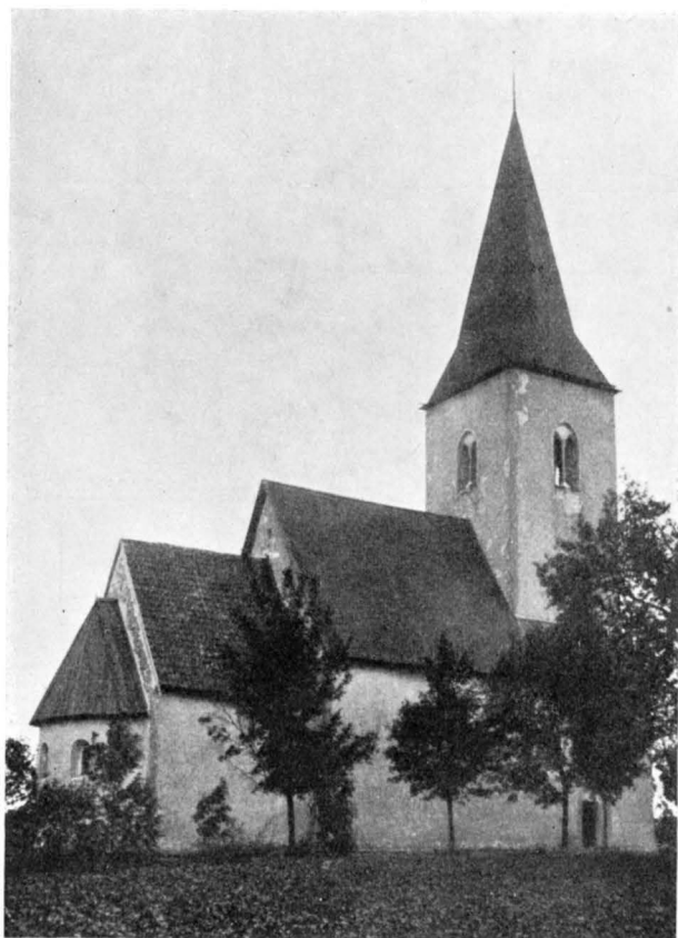
Fig. 429. Hejdeby kyrka. Exteriör från nordost. Die Kirche von Nordosten.
