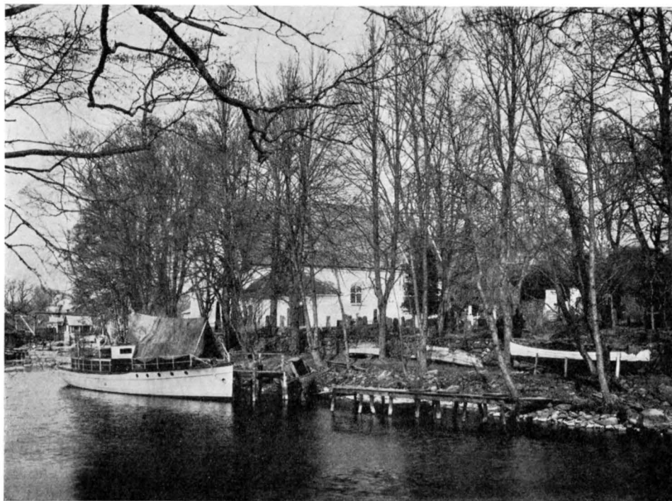
Fig. 200. Nättraby kyrka. Exteriör från söder med ån och hamnen. — Foto Alfr. Edle 1930. Aussenansicht von Süden. — Exterior from the south.
