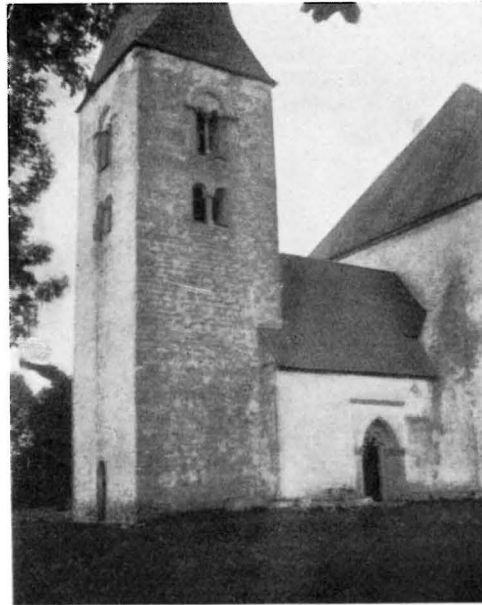
Fig. 292. Exteriör av »gammalkyrkan» från sydväst. Foto J. Roosval 1913. Aussenansicht des ältesten Teiles der Kirche vom SW. Vielleicht 1072, der obere Teil des Turmes und das Südportal gotisch.
