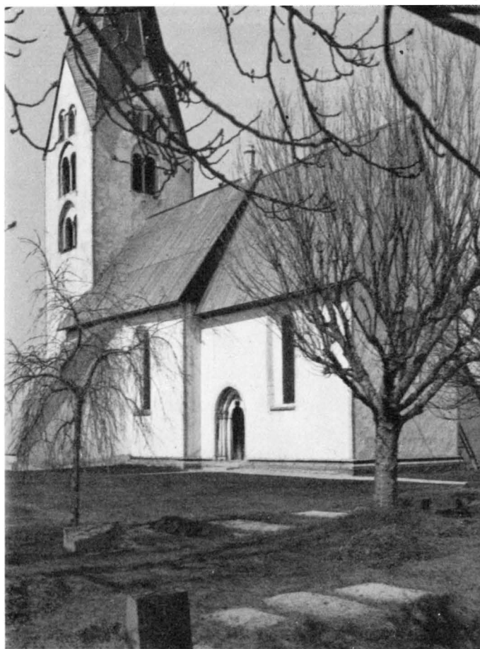
Fig. 218. Exteriör från sydost. Aussenansicht von SO.
