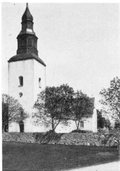
Fig. 2. Exteriör från s. v. Aussenansicht von SW.
