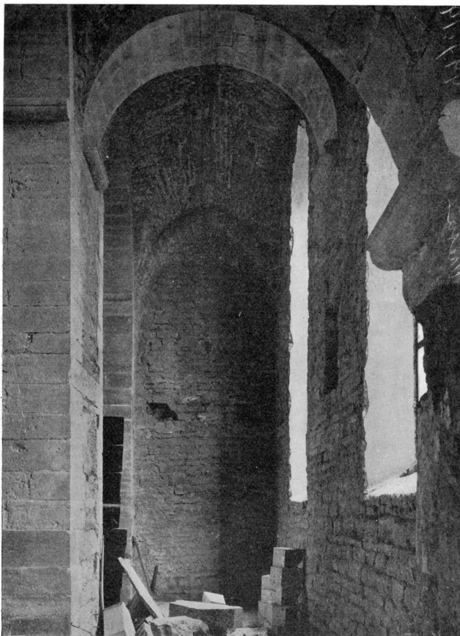
Fig. 51. Norra sidoskeppet från öster under restaureringsarbetet. Murytorna renknackade från puts. Observera valvens konstruktion.
