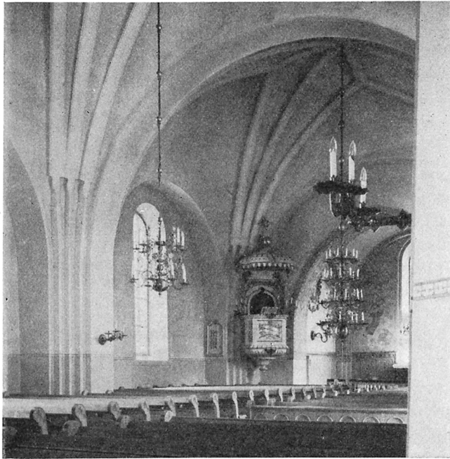
Fig. 96. Valbo kyrka. Interiör mot öster. Foto Edle 1930. Inneses gegen Osten. Interior towards the east.
