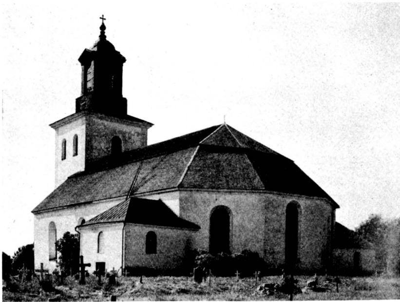
Fig. 309. Torsåkers kyrka. Foto Andréén 1930. Aussenansicht von Sydosten. Exterior from the south-east.
