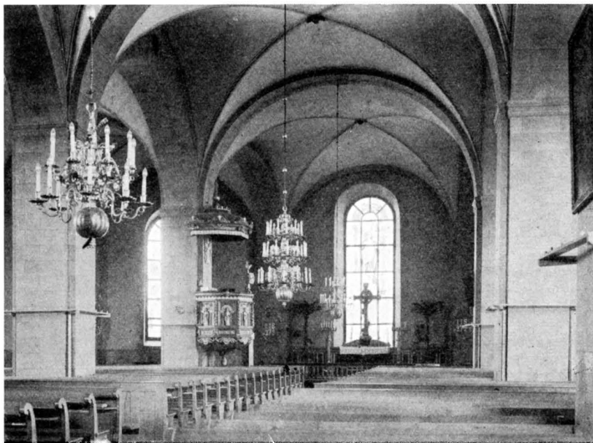
Fig. 310. Torsåkers kyrka. Interiör mot öster. Foto Andrén 1930. Inneses gegen Osten. Interior towards the east.
