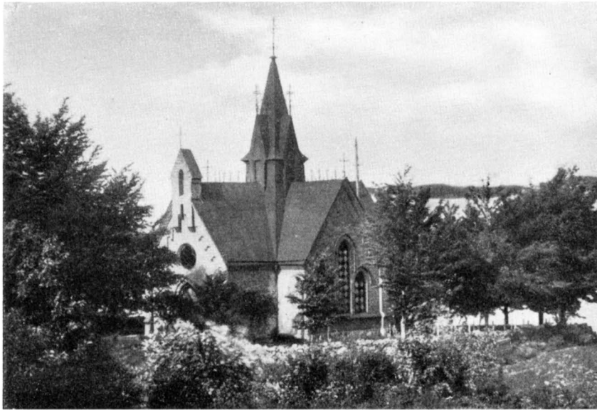
Fig. 121. Exteriör från sydväst. Äusseres von Südwesten. Exterior from the south-west.
