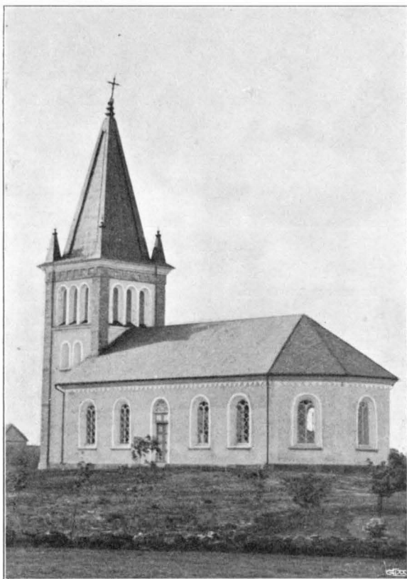
Fig. 313. Häggesleds nya kyrka från sydost. Die neue Kirche von Südosten.
