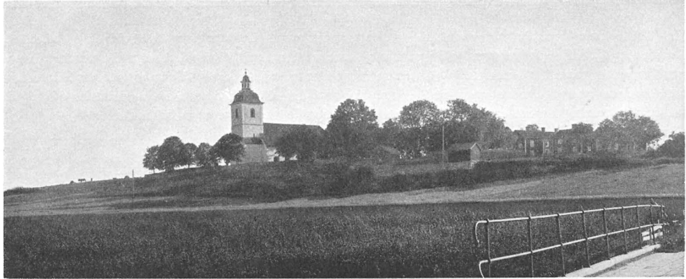
Fig. 66. Svinstads kyrka från bron över Bjärstad-ån. Foto 1916.
