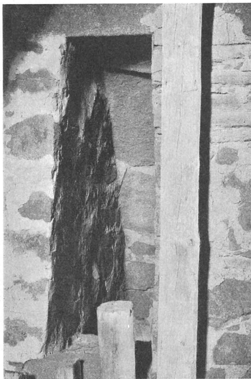
Fig. 76. Svinstad. Norra portalen i tornvån. 2 tr. upp. Foto 1916.
