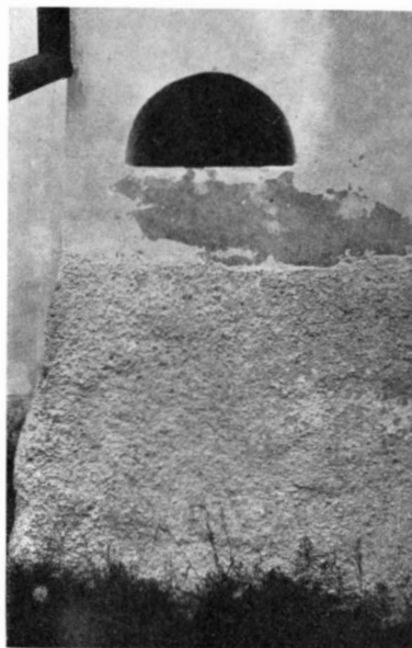
Fig. 157. Örtomta. Vigvattensnisch å södra sidan. Foto 1916. Weihwasser-Nische an der südlichen Seite Holy-water niche on the south side.
