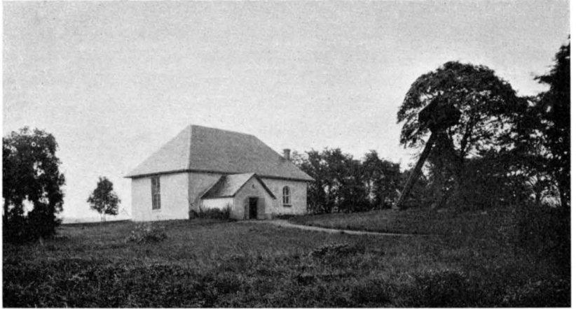
Fig. 406. Gillstad. Exteriör från sydväst. Foto A. Roland 1912. Äusseres von Südwesten.
