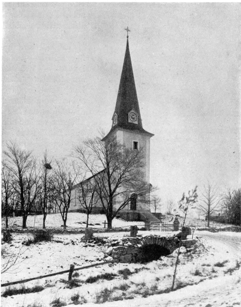
Fig. 341. Örslösa kyrka från väster. Äusseres der Kirche von Westen.
