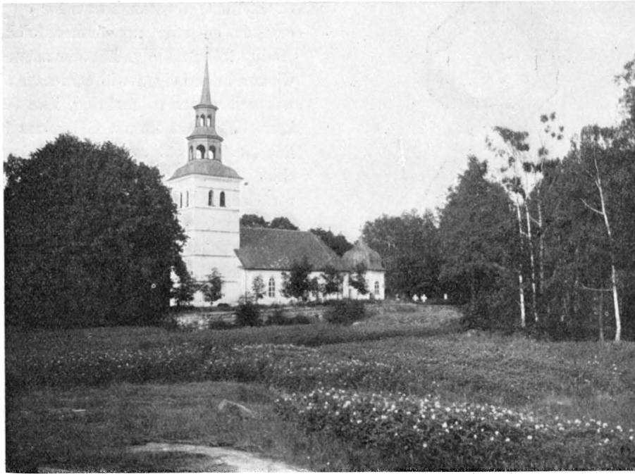
Fig. 39. Borgvik. Exteriör från sydväst. — Foto 1912. Die Kirche von Südwesten. — The church from the south-west.
