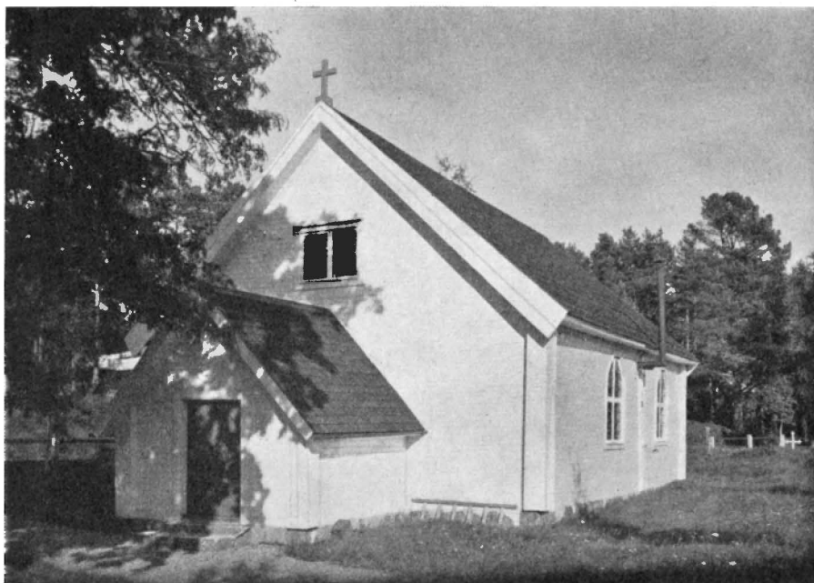
Fig. 36. Galtströms kapell. Exteriör från sydväst. Das Äussere von Südwesten. The exterior from the south-west.
