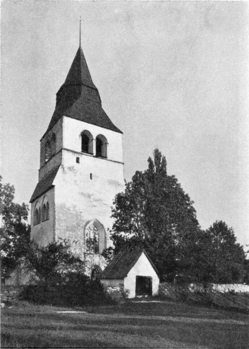
Fig. 380. Lokrume kyrka. Exteriör från nordväst. Aussenansicht von Nordwesten.
