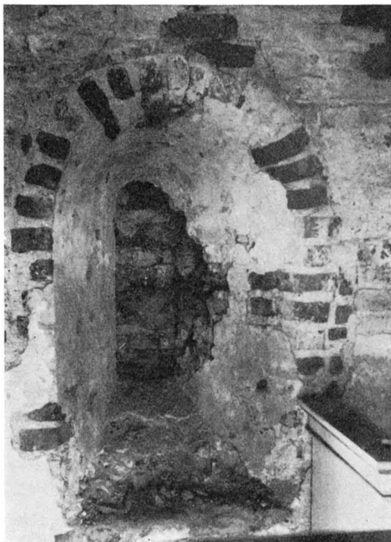
Fig. 28. Grinstad kyrka. Fönsternisch i kyrkans södra mur. — Foto 1913.
