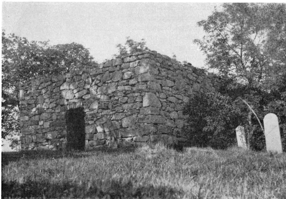
Fig. 62. Erikstads »mellan»-kyrka. Ruinen från sydväst före restaureringen 1928. Die alte Kirche zu Erikstad. Die Ruine von Südwest, The second church at Erikstad. The ruin from the South- vor der Restaurierung 1928. West, before its restoration, 1928.
