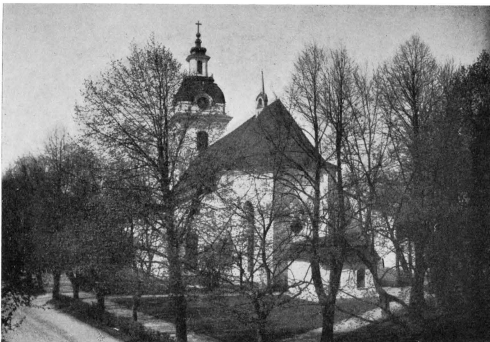
Fig. 11. Heliga Trefaldighets kyrka från sydost. Foto Reimers 1931. Aussenansicht von Südosten. Exterior from the south-east.
