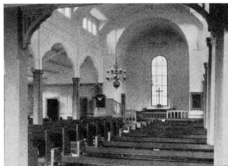
Fig. 94. Bomhus kapell. Interiör mot Ö. Kapelle Bomhus. Inneres gegen Osten. Chapel Bomhus. Interior towards the east.
