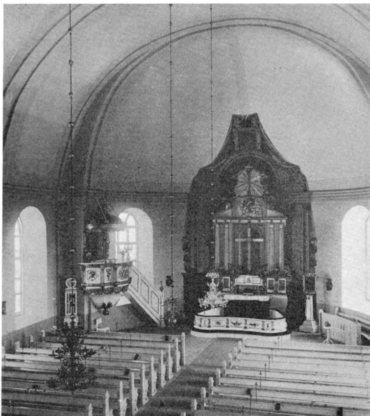
Fig. 233. Interiör mot koret.
