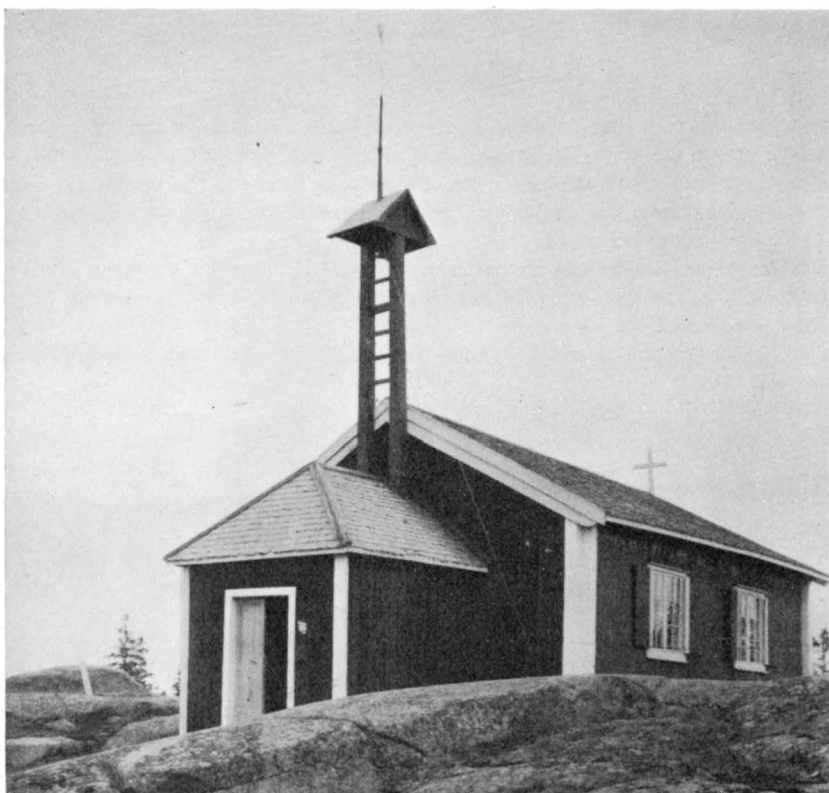
Fig. 138. Exteriör av Skeppshamns kapell.
