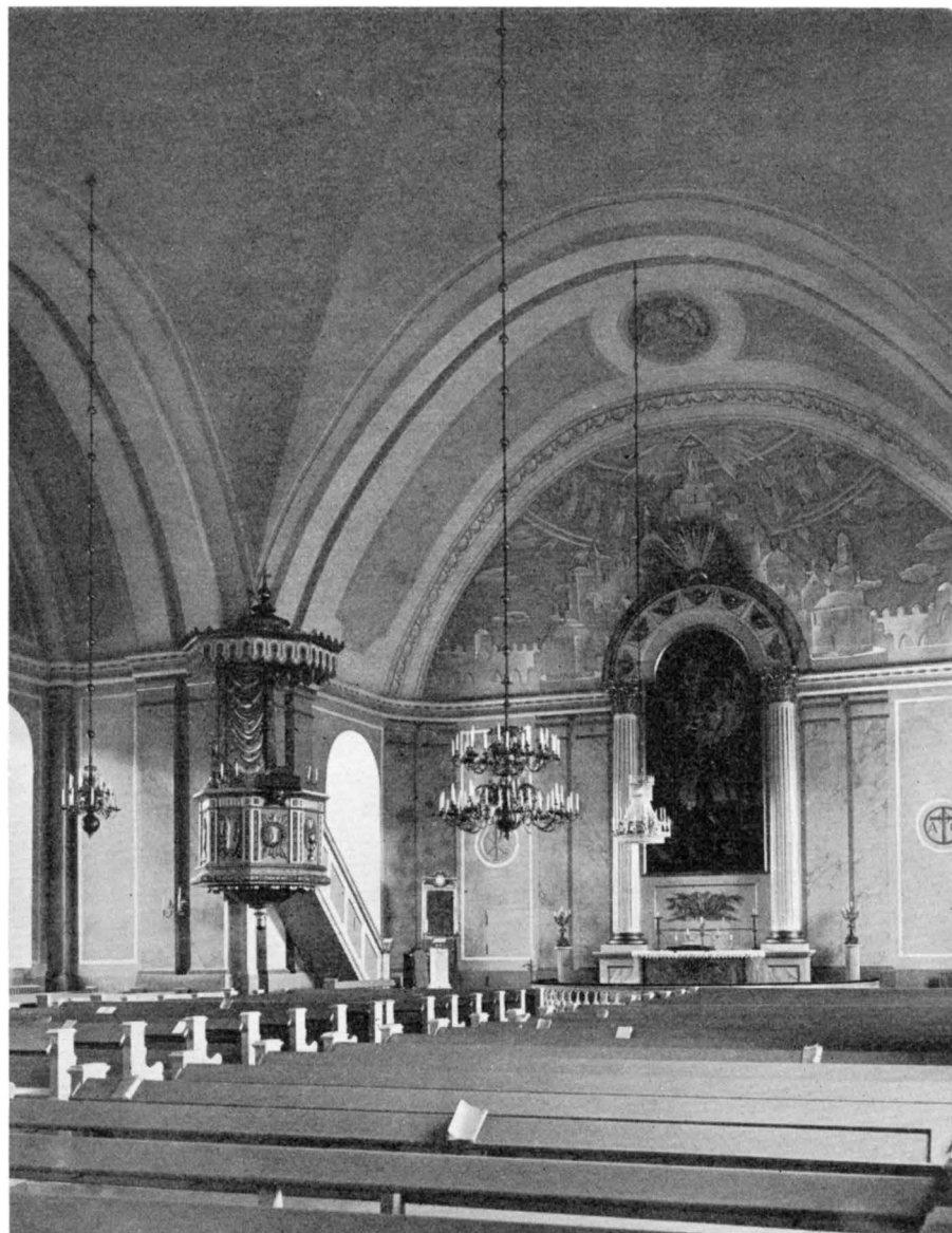
Fig. 306. Interiör mot öster.
