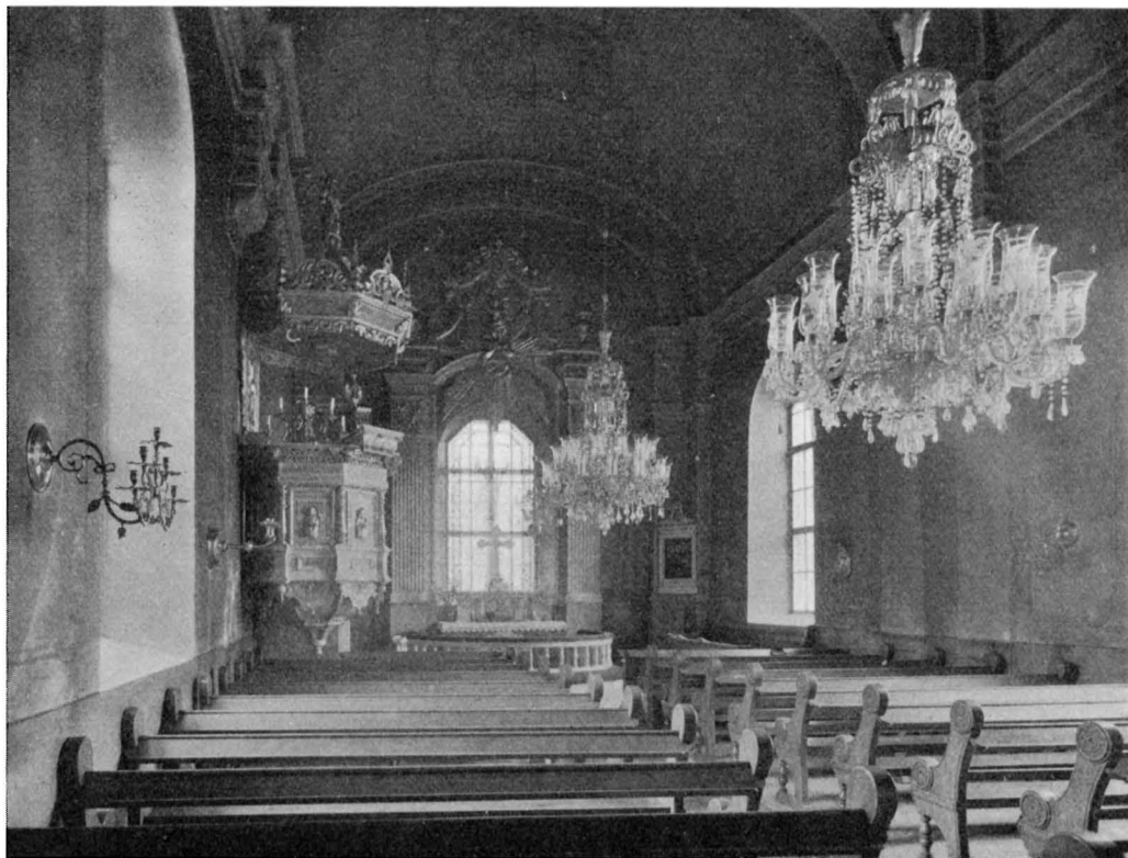
Fig. 132. Interiör mot öster.
