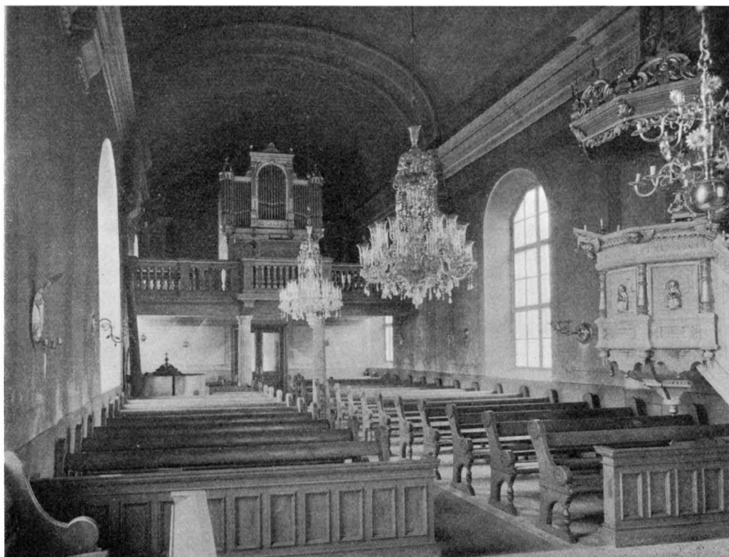
Fig. 133. Interiör mot väster.
