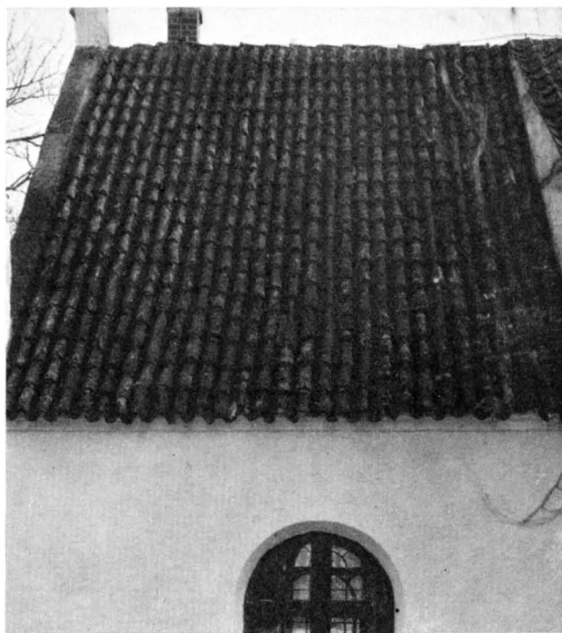
Fig. 125. Munkpannor på korets n. takfall. Mönchdachziegel auf der nördlichen Dachfläche des Chors. Roofing tiles upon the northern roof truss of the chancel.
