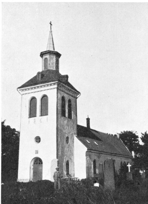
Fig. 121. Exteriör från s. v. Auseres von Südwesten. — Exterior from the south-west.
