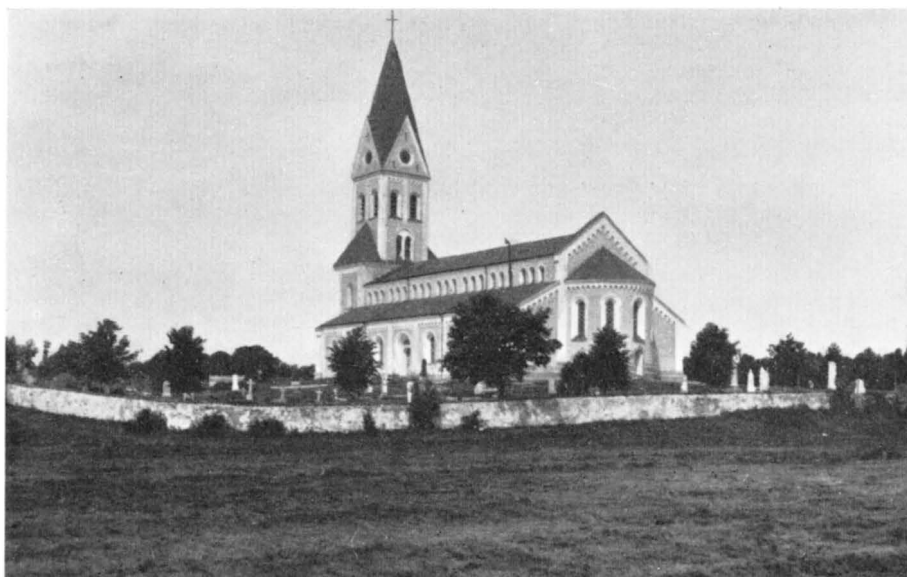
Fig. 1. Exteriör från s. o. Äusseres von Südosten. — Exterior from the south-east.
