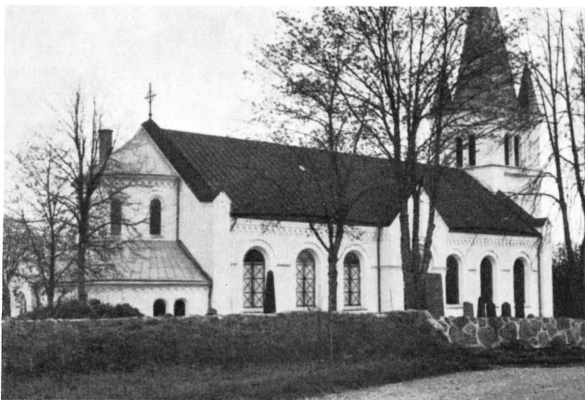
Fig. 57. Exteriör från n. v. Äusseres von Nordwesten. — Exterior from the north-west.
