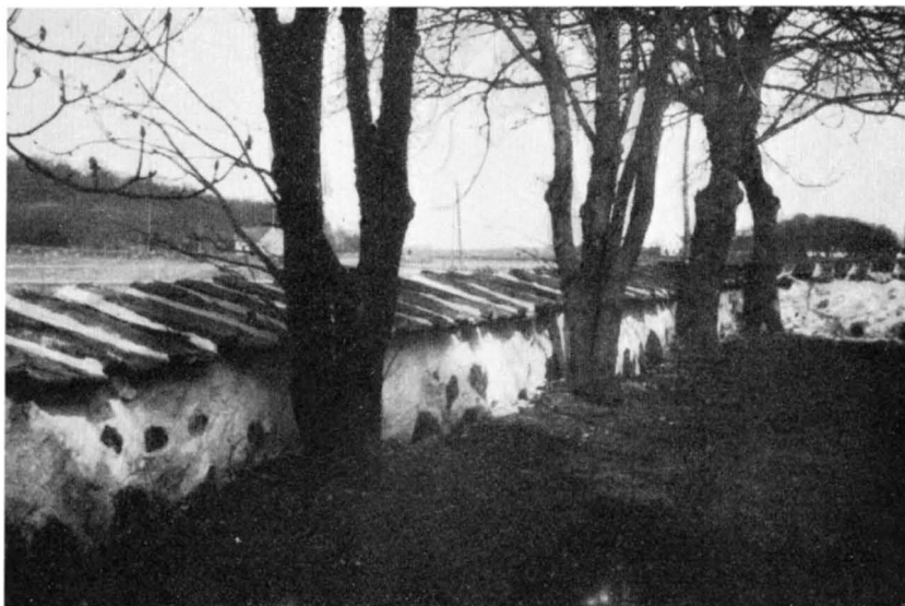
Fig. 122. Parti av kyrkogårdsmuren. Partie der Kirchhofsmauer. — Part of the wall of the churchyard.
