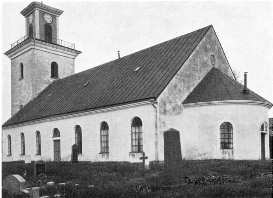
Fig. 85. Exteriör från s. o. Äusseres von Südosten. — Exterior from the south-east.
