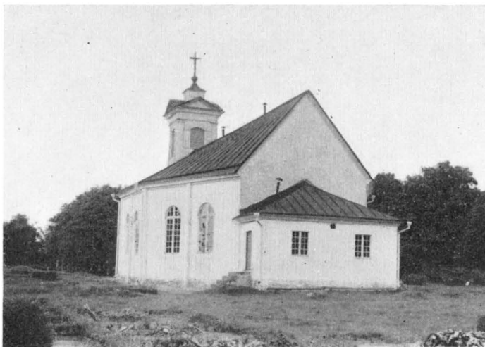
Fig. 18. Exteriör från s. o. Äusseres von Südosten. — Exterior from the south-east.
