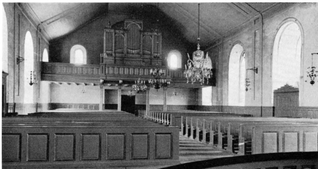
Fig. 37. Interiör mot v. Inneres gegen Westen. — Interior towards the west.
