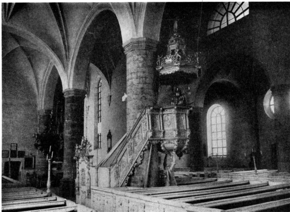
Fig. 105. Interiör mot nordöst före restaureringen 1903—06. Inneses gegen Nordosten. Vor 1906. Interior towards the northeast before 1906.
