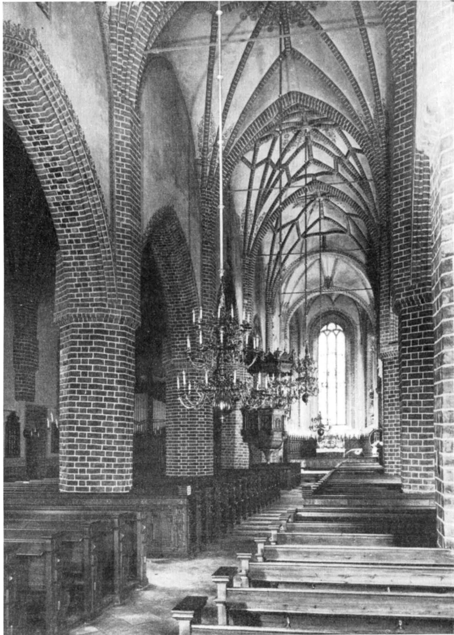
Fig. 13. Interiör mot öster. Foto S. Nilsson 1941. Inneres gegen Osten. 1941. Interior towards the east. 1941.
