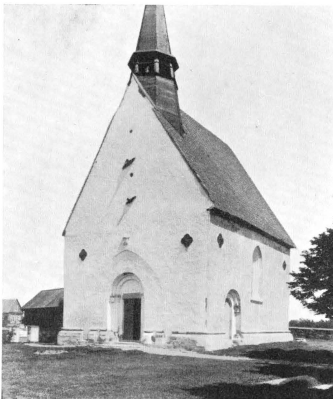
Fig. 181. Exteriör från s.v. Aussenansicht von SW.
