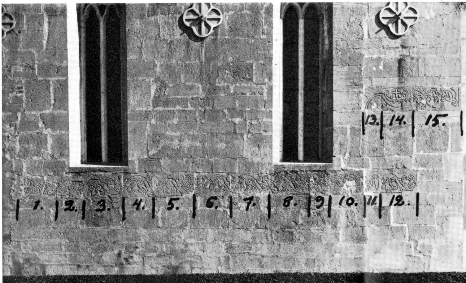
Plansch I a. Sanda. Palmettfris på s. långhusmuren från mitten av 1000-t., återanvänd i 1200-t:s mur i bruten ordning. Palmettenfries an der S. Langhausmauer. Mitte des 11. Jahrh. Wieder in der Mauer des 13. Jahrh. benützt, obgleich in gebrochener Ordnung.
