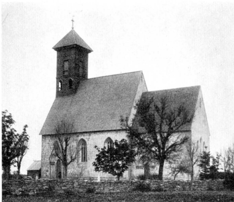
Fig. 313. Exteriör från s.ö. före 1914. Foto i A. T. A. Aussenansicht von SO.
