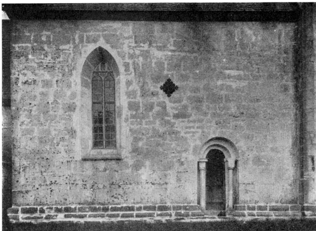
Fig. 205. Exteriör från n. Aussenansicht von N.
