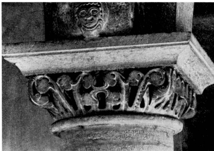
Fig. 85. Kolonnkapitålet i långhuset. Das Säulenkapitell des Langhauses.
