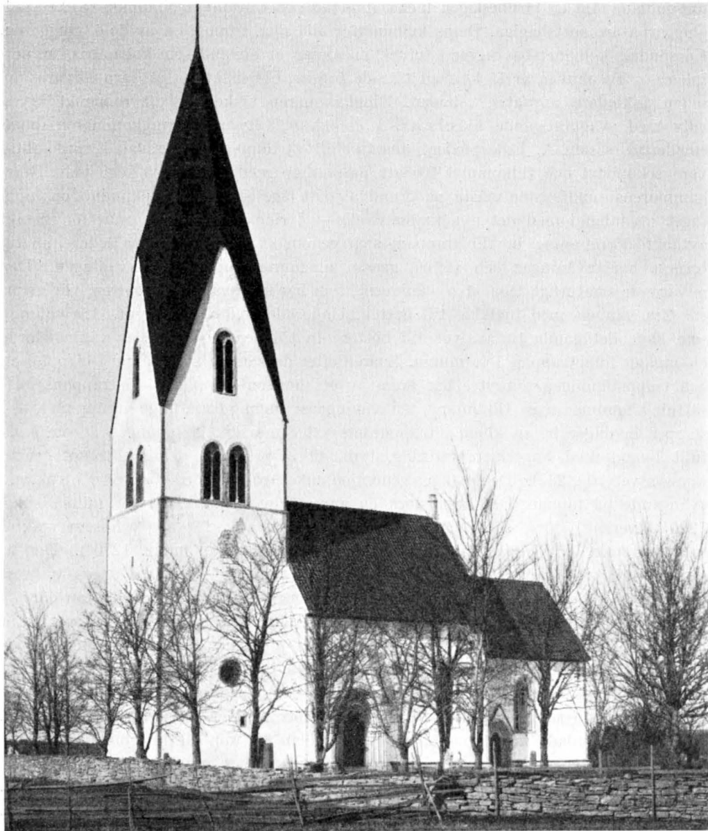
Fig. 243. Exteriör från s.v. Aussenansicht von SW.
