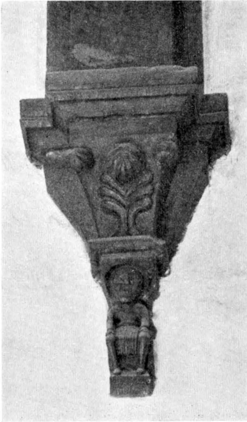
Fig. 157. V. konsol i s. långhusväggen. W. Konsole in der s. Langhausmauer.
