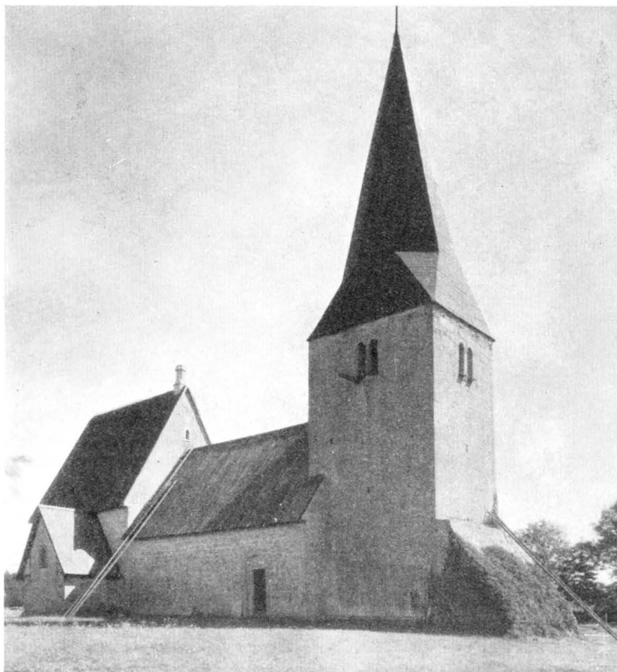
Fig. 414. Exteriör från n.v. Foto H. Faith-Ell 1931. Das Äussere von NW.
