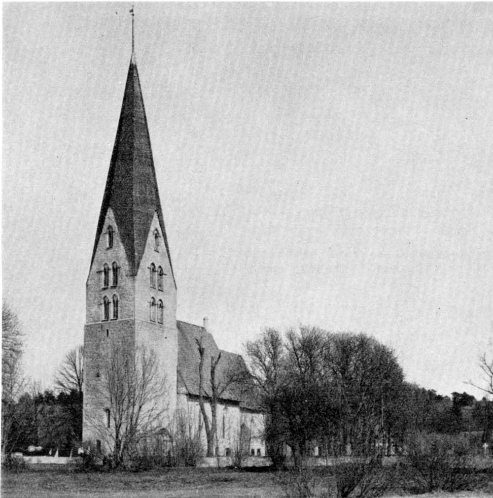
Fig. 365. Exteriör från s.v. Aussenansicht von SW.
