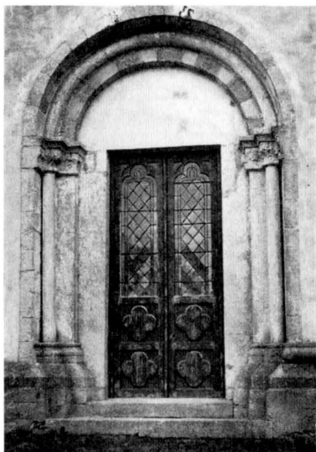
Fig. 78. Tornets n. portal. Foto E. Erics 1914. Das N.-Portal des Turmes.
