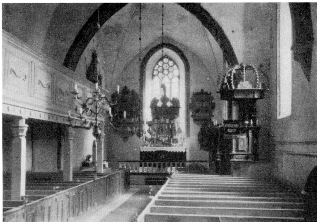
Fig. 385. Interiör mot ö. före restaureringen 1933. Foto i A. T. A. Das Innere gegen O. vor der Restaurierung 1933.
