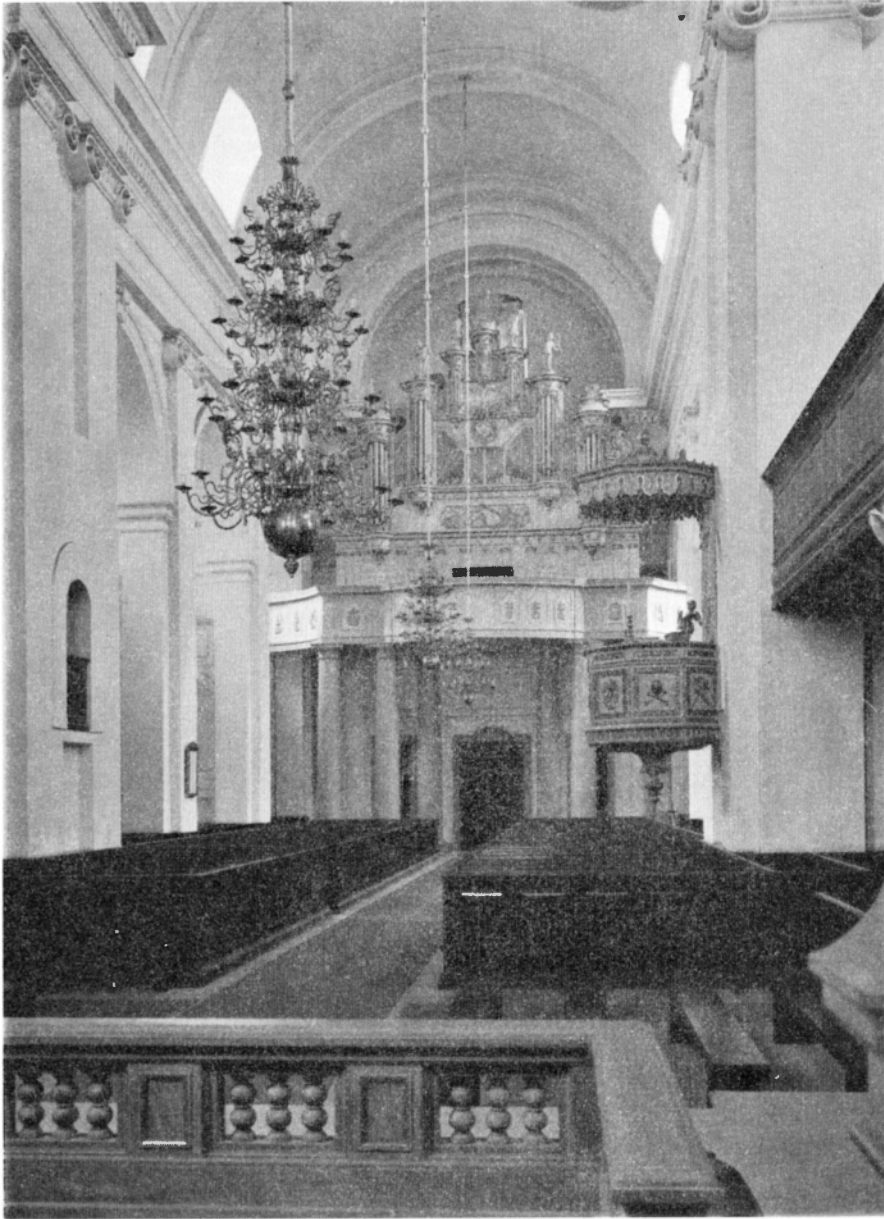
Fig. 10. Interiör mot väster. Innes gegen Westen. Interior towards the west.
