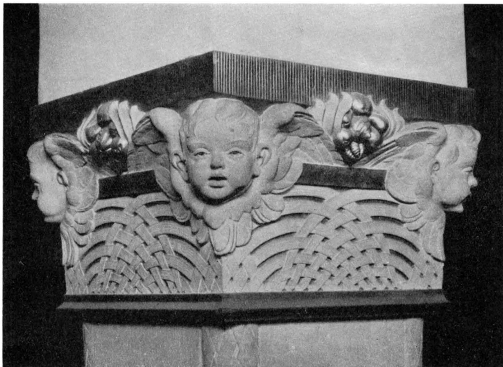
Fig. 152. Pelarkapital av huggen och delvis förgylld kalksten. Foto N. Lagergren 1945. Pfeilerkapitelle aus behauenen und teilweise vergoldetem Kalkstein. Pillar capital of dressed and partially gilded limestone.
