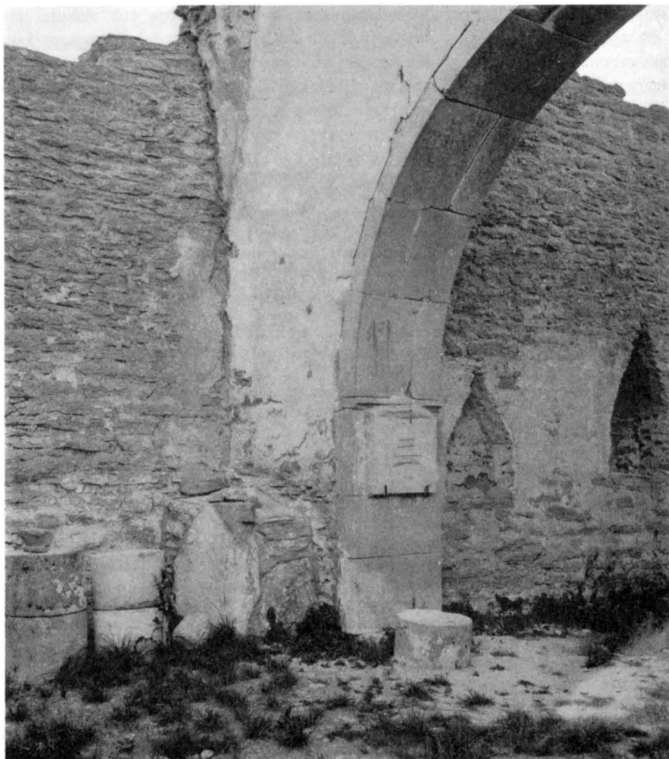
Fig. 18. Interiör åt n. Foto A. Edle 1925. Das Innere gegen N. Interior towards the N.
