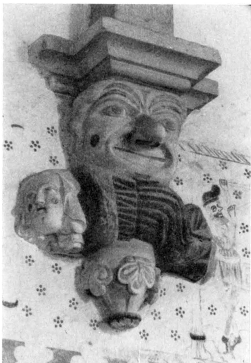
Fig. 150. Gördelbågens n. konsol i långhuset. Die N. Konsole des Gurt- Corbel in the nave, n. bogens im Langhause. wall.
