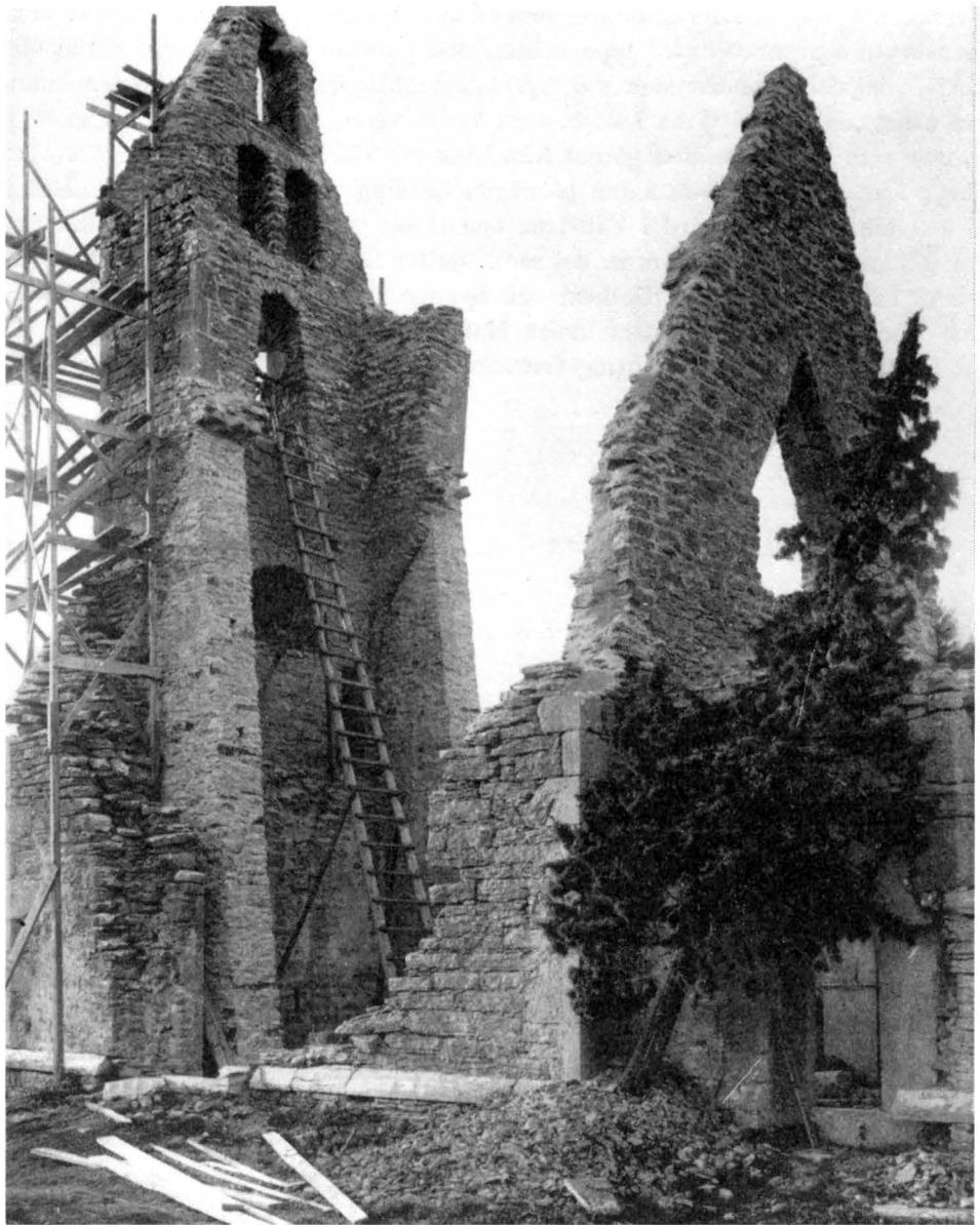
Fig. 1. Långhuset med tornet fr. s. o. med nyuppförda strävpelare. Foto A. Edle 1923. Langhaus und Turm von SO mit neuerbauten Nave and tower from the S. E. with new-built Streben. buttresses.
