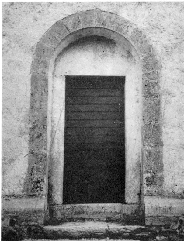
Fig. 45. N.-portalen. Foto E. Erics 1914. Das N.-portal. The N. portal.
