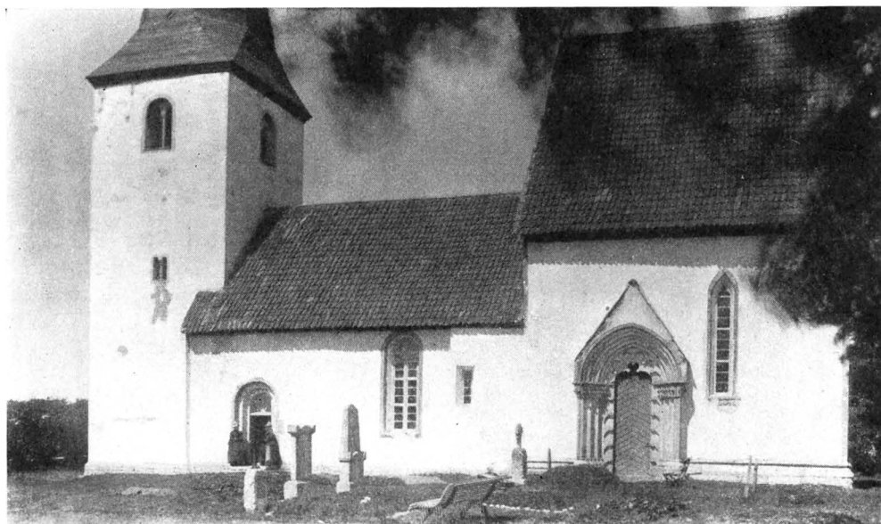
Fig. 289. Exteriör från S. Foto B. Sahlin omkr. 1900. Aussenansicht von S. Exterior from S.
