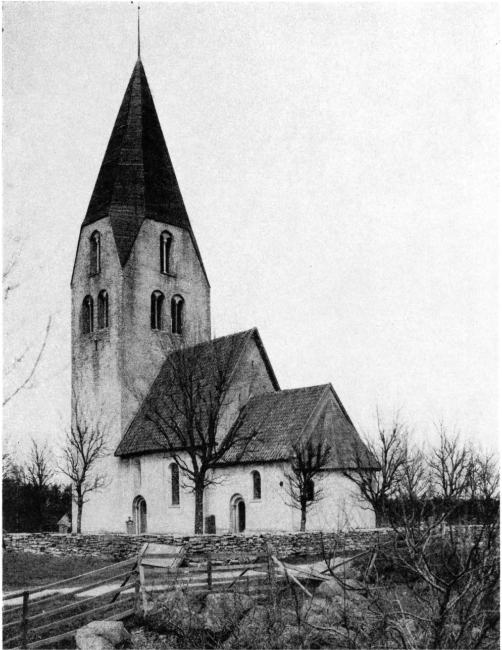
Fig. 235. Ganthems kyrka från SÖ. Foto 1928. Ansicht von SO. Ganthem church from S.E.
