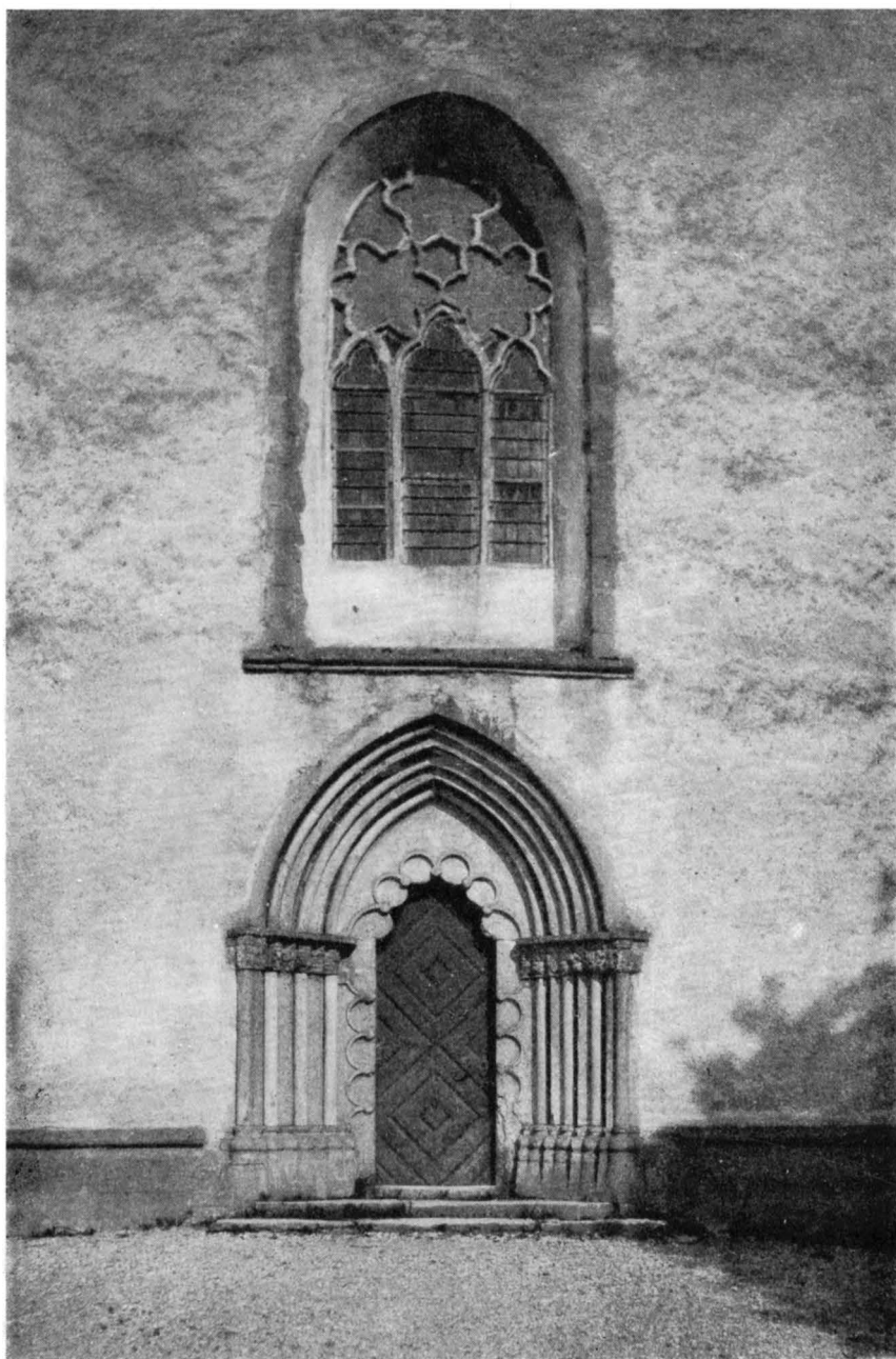
Fig. 194. V-portalen och V tornfönstret före restaureringen. Foto Olivia Wittberg 1901.
