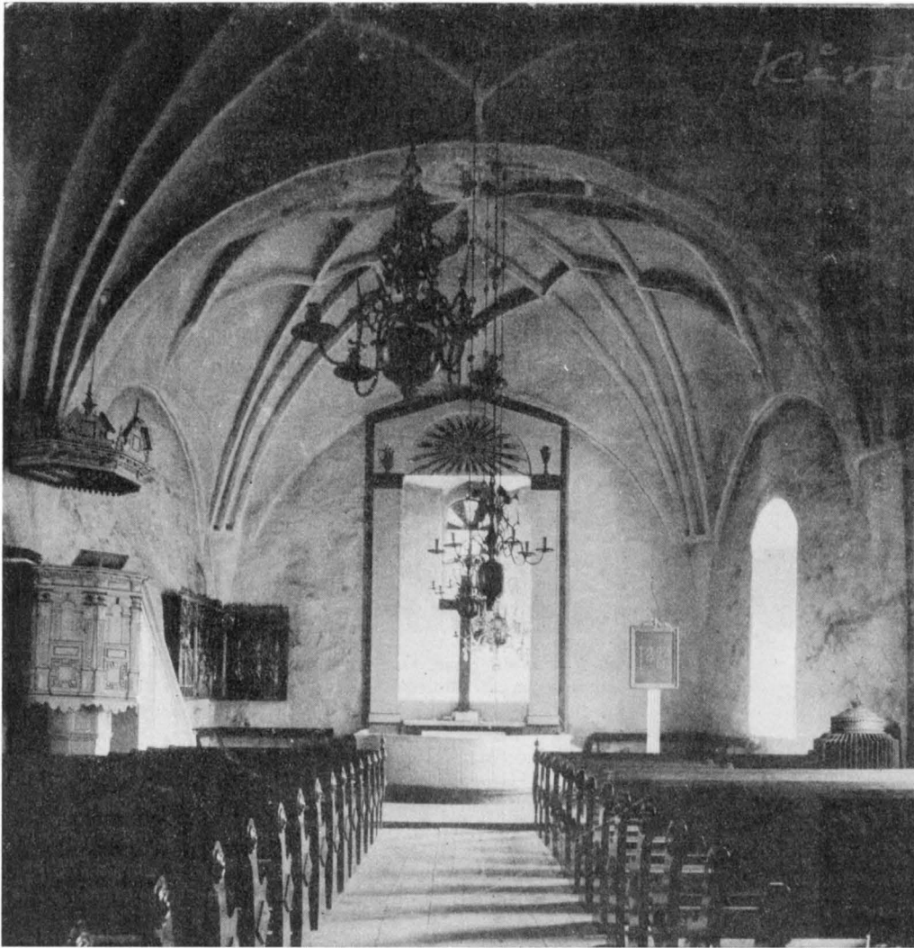
Fig. 232. Interiör mot Ö. Foto före restaureringen 1901.
