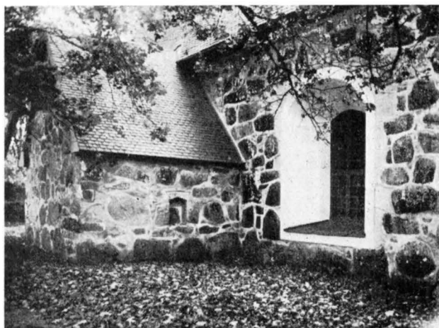
Fig. 231. Sakristian från NV. Foto 1917. Die Sakristei von NW. Vestry from NW.
