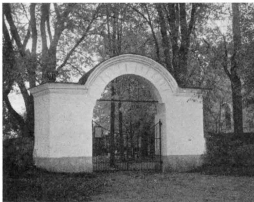
Fig. 181. Kyrkogårdsportal från 1770. Foto 1948. Kirchhofportal 1770. Lychgate 1770.
