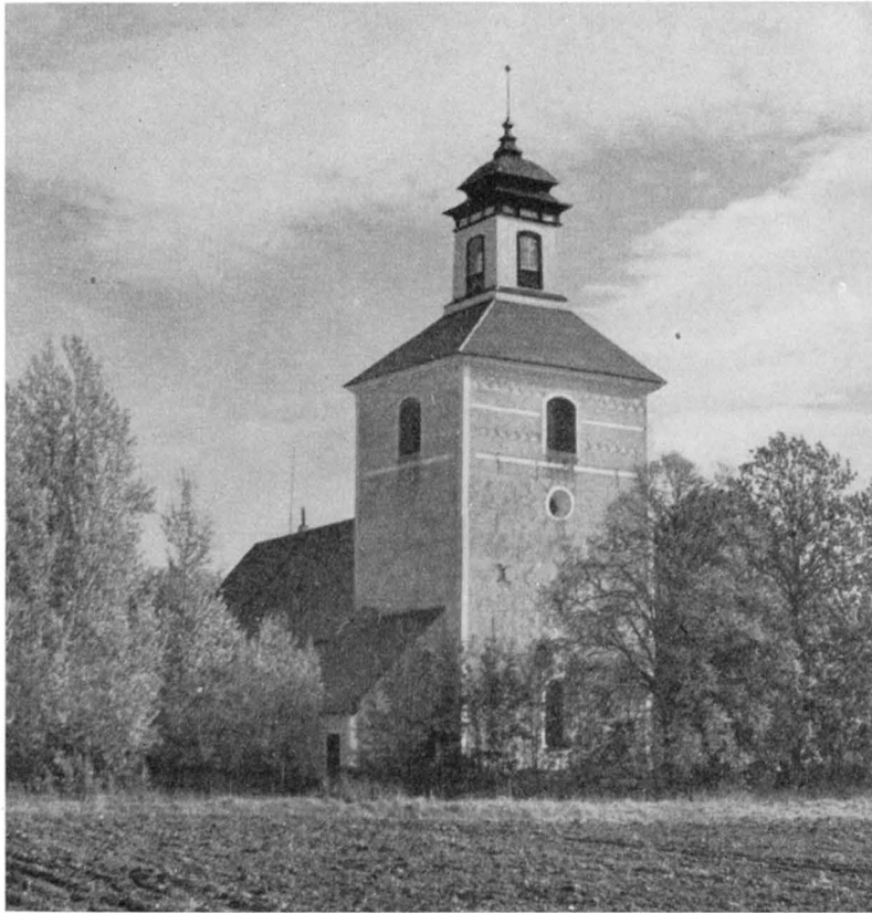
Fig. 192. Tornet från NV. Foto 1948. Der Turm von NW. The tower from NW.
