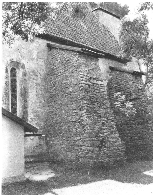
√ Fig. 461. Strävpelare på långhusets N-sida. Foto 1941. Strebepeiler an der Norwand des Langhauses. Buttresses N. of nave.
