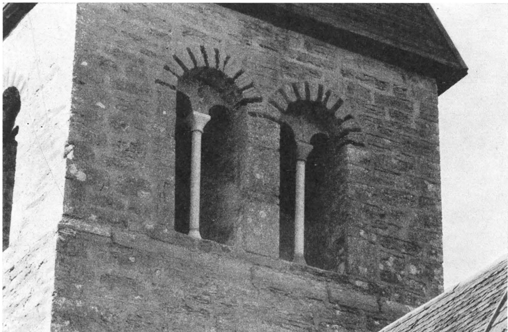
Fig. 384. Tornet med ljudgluggar från SÖ. Vänstra kolonnetten (hela) och högra kolonnettskaffet nya. Foto 1950.
