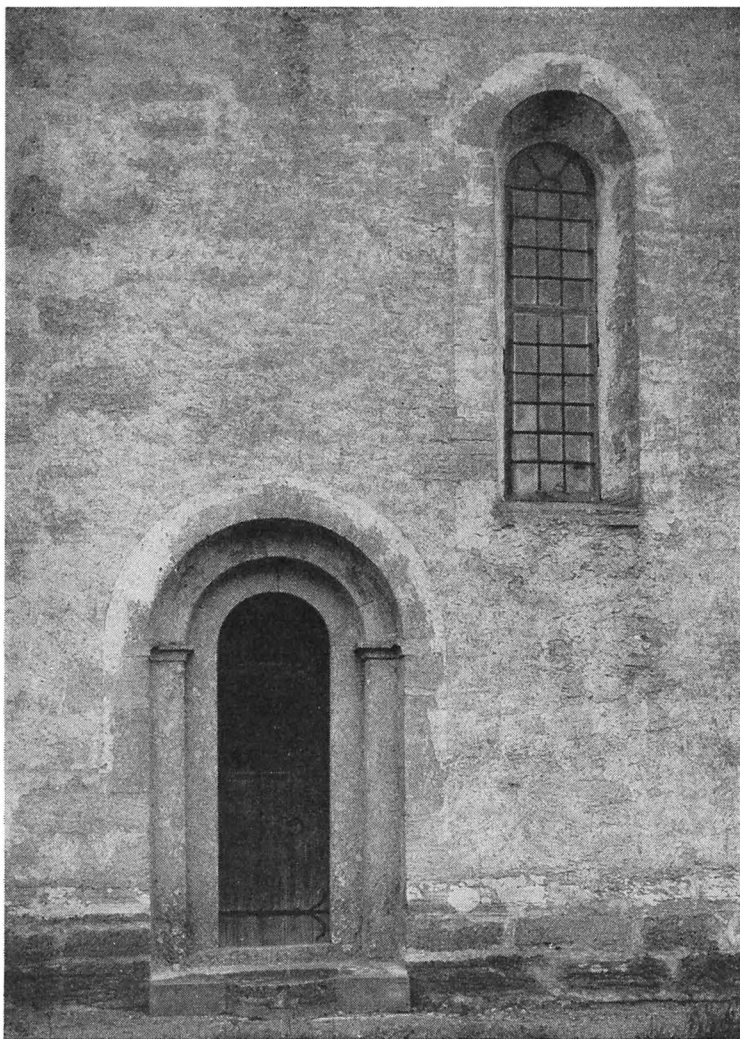
✓ Fig. 329. Portal och fönster i S korväggen omkr. 1230.
