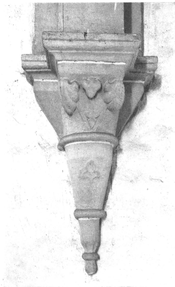
/ Fig. 481. Kragsten på långhusets S vägg. Foto 1928. Kragstein an der Südwand Corbel in S. wall of nave. des Langhauses.
