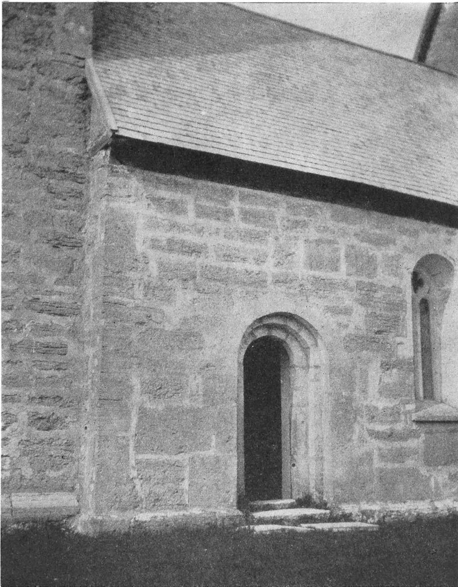
✓ Fig. 383. Långhuset's S-portal. Foto J. Roosval. Südportal des Langhauses. S. doorway of nave.
