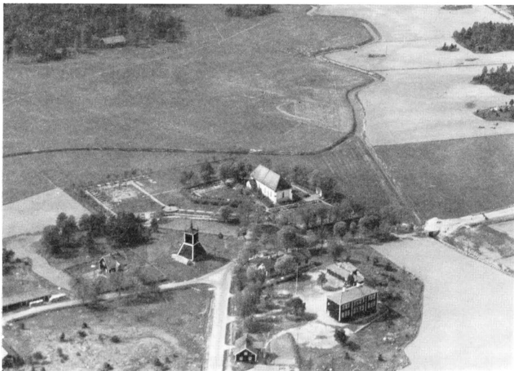
Fig. 252. Kyrkans belägenhet, sedd från luften. Foto O. Bladh 1937. Luftbild der Kirche und ihrer Umgebung. The church and its surroundings. Aerial photo.
