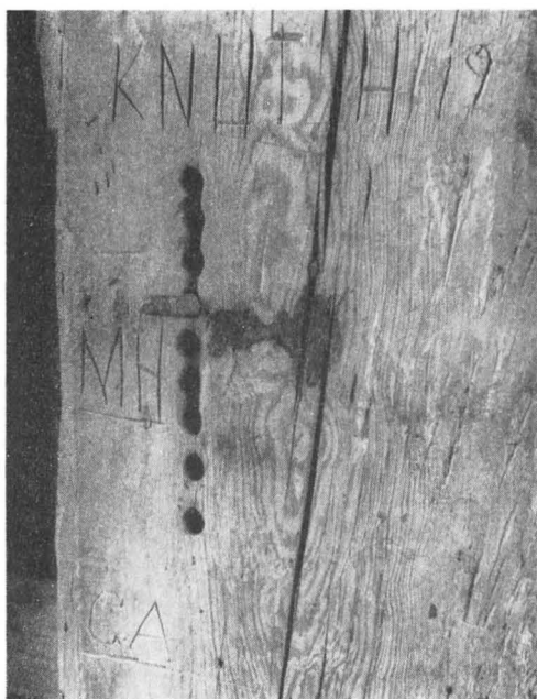
Fig. 467. Parti av S hjärtstocken (i klockvåningen) med 9 hål för att räkna slagen vid klämtningen. Foto 1947. S. 437.
