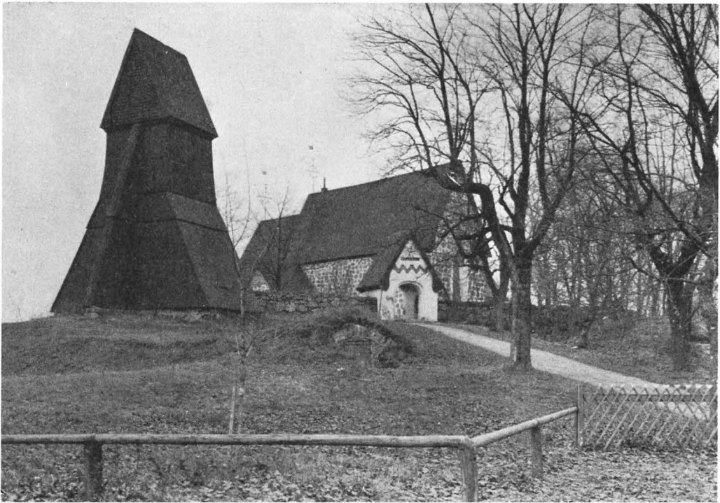
Fig. 460. Kyrkan och klockstapel från NV. Foto 1915. Kirche und Glockenstapel von NW. Church and bell-tower from N.W.
