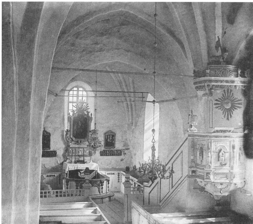
Fig. 476. Interiör mot Ö före restaureringen 1904. Foto O. Janse 1904. Innenansicht gegen O vor der Restaurierung von 1904. The interior towards the E., prior to the restoration of 1904.
