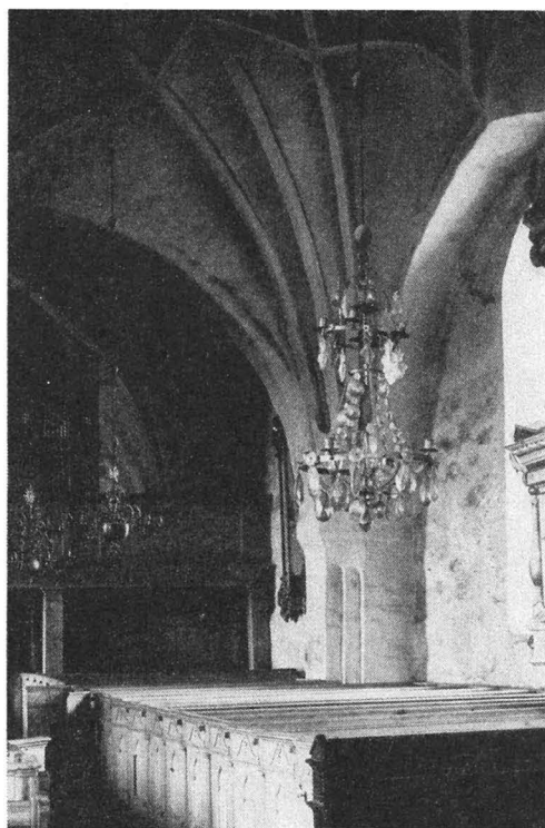
Fig. 528. Interiör mot NV före restaureringen 1897. Foto B. Almquist 1897. Innenansicht gegen NW Interior towards N.W. vor der Restaurierung von before restoration in 1897. 1897.
