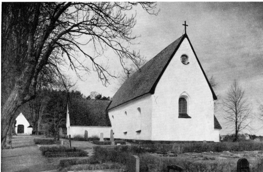
Fig. 179. Kyrkan från SÖ. Foto 1948. Die Kirche von SO. Church from SE.
