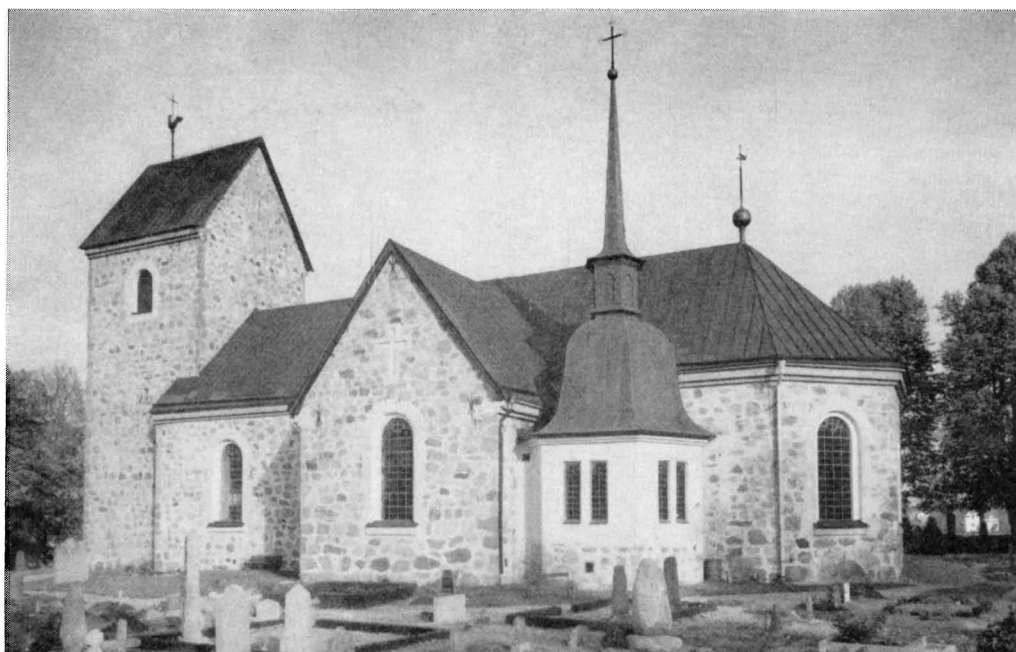
Fig. 111. Kyrkan från SO efter restaureringen 1937. Foto 1948.
