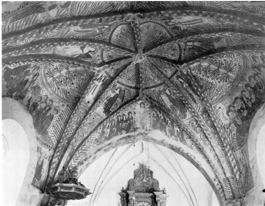
Fig. 695. Ö delen av valvet travé II. Foto O. S. Ö. Teil des Gewölbes in Joch II. E. part of vaulting of bay II.
