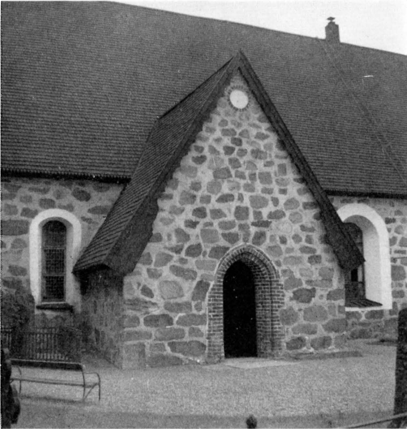
Fig. 674. Vapenhuset från S. Foto 1954. Vorhalle, »Waffenhaus» von S. Porch from S.
