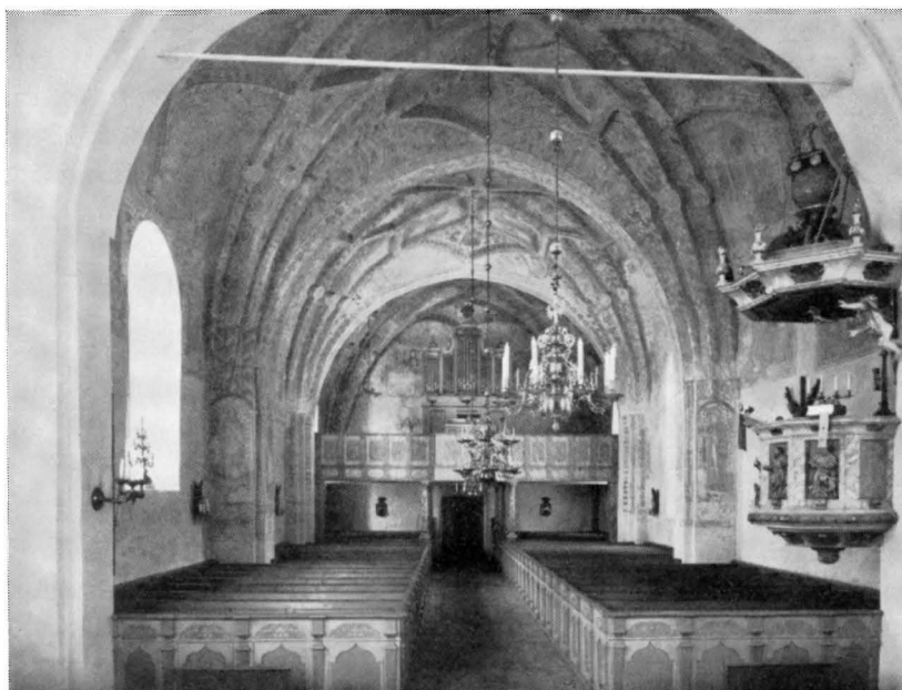
Fig. 558. Interiör mot V. Foto 1955. Kircheninneres nach W. Interior towards W.
