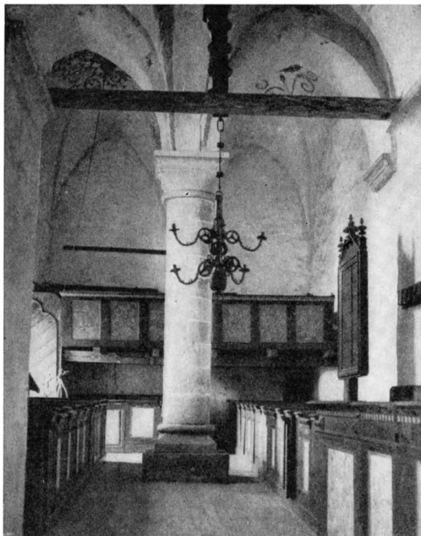
Fig. 587. Interiör mot V före restaureringen 1946—47. Foto E. Erics 1916.
