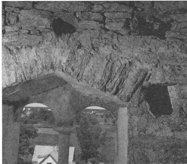
Fig. 656. Bjälkhål i tornets klockvåning. Foto 1958.
