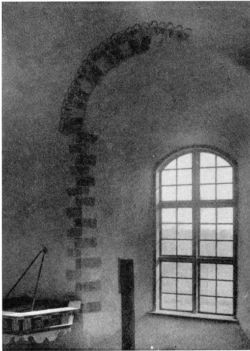
Fig. 592. Långhusets Ö fönster med ornamental dekor från 1280-talet. Foto A. Edle 1946.
