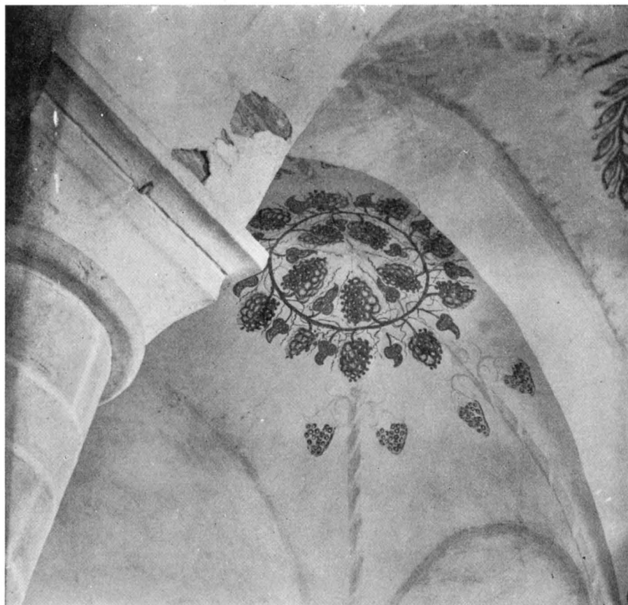
Fig. 590. Långhusets NÖ valv före restaureringen 1946—47 med dekor från 1748. Foto J. Roosval.
