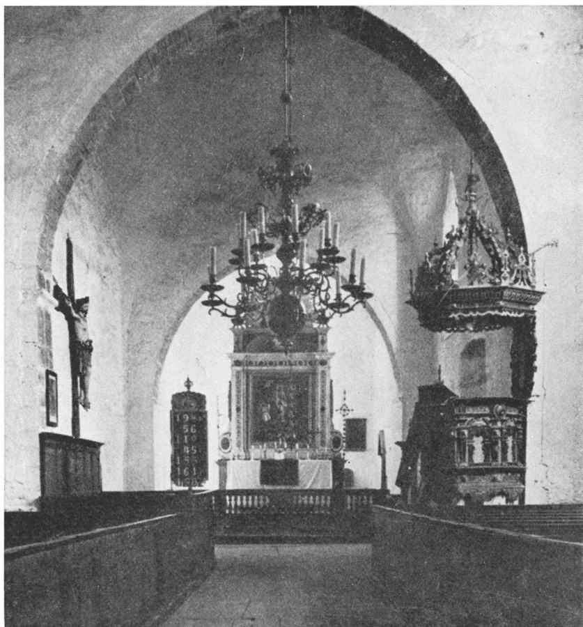
Fig. 523. Interiör mot Ö före restaureringen 1908—10. Foto omkr. 1900.
