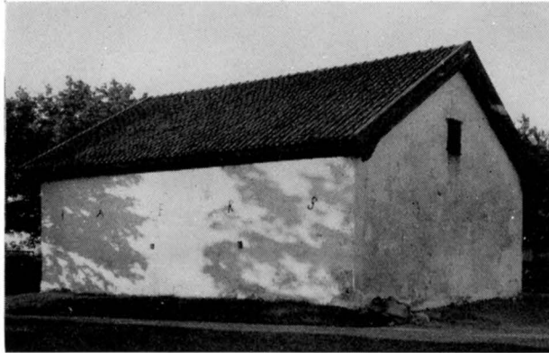
Fig. 322. F. d. sockenmagasin, uppfört 1758, nu bårhus. Foto 1958. Der 1758 errichtete frühere Gemein- The former parish repository, despeicher, jetzt Leichenhalle. built 1758, now mortuary chapel.
