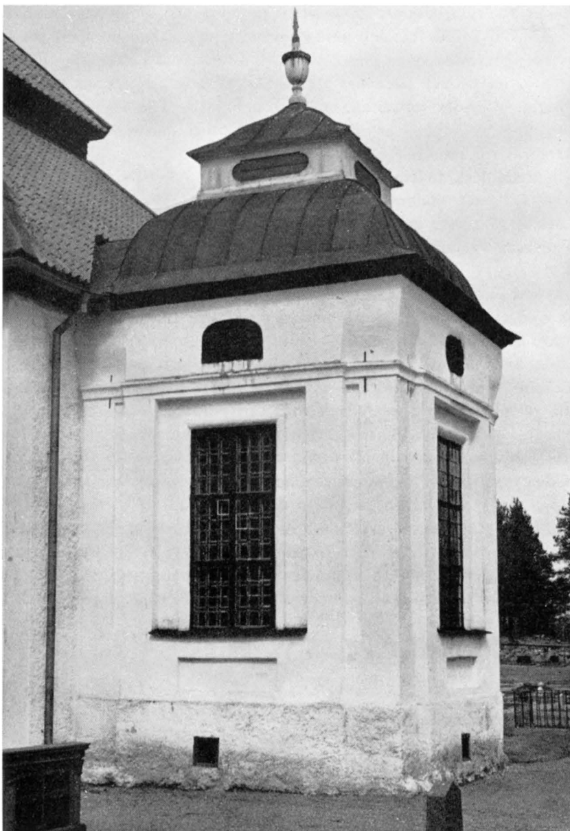
Fig. 356. Reuterska gravkoret från SÖ. Uppfört 1678—79. Foto 1960. — S. 400 Die Reutersche Grabkapelle von SO, Reuter burial chapel from SE. Built 1678—79. errichtet 1678—79.
