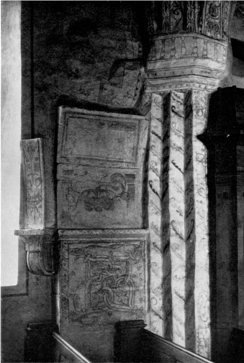
Fig. 348. Rester vid e å fig. 332 av anfang till triumfbåge mellan äldre långhus och kor samt av konsolburen diagonalbåge till detta äldre korvalv. Foto N. Åzelius 1935.
