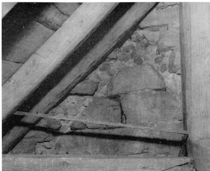
Fig. 359. Detalj av västgavelns röste S om tornet, sedd från kyrkvinden. Bilden visar den äldsta stenkyrkans takfall. Foto 1958.
