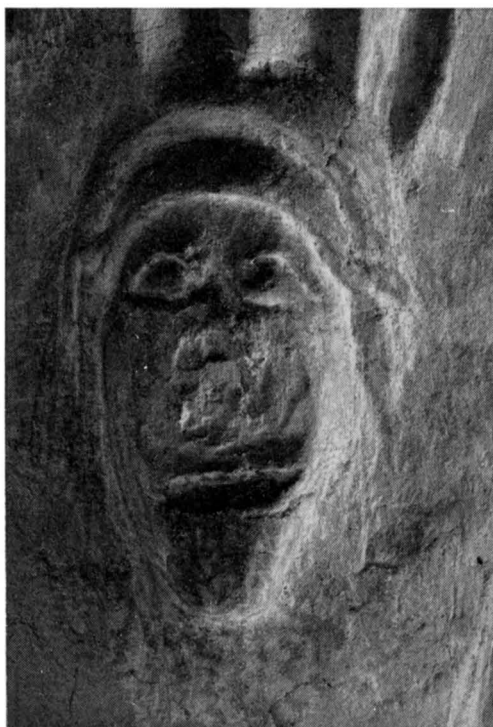
Fig. 351. I puts modellerad mask under valvanfang på S långhusväggen vid b å fig. 332.
