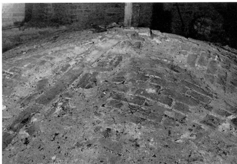
Fig. 279. Översidan av långhusets mellersta valv. Foto 1960.
