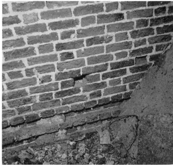
Fig. 269. Utsparning över valven i S långhusmuren. Foto 1960. S. 340.
