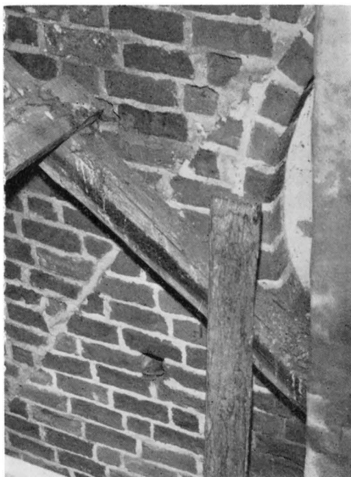
Fig. 264. Fog mellan korgavel och långhusgavel. Foto 1960.
