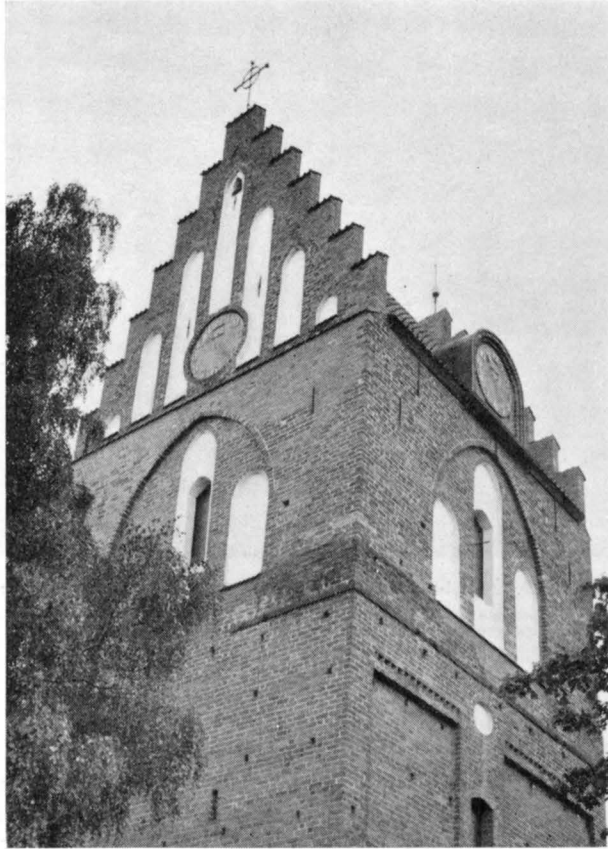
Fig. 278. Tornet från NV. Foto 1960 Der Turm von NW. Tower from NW.
