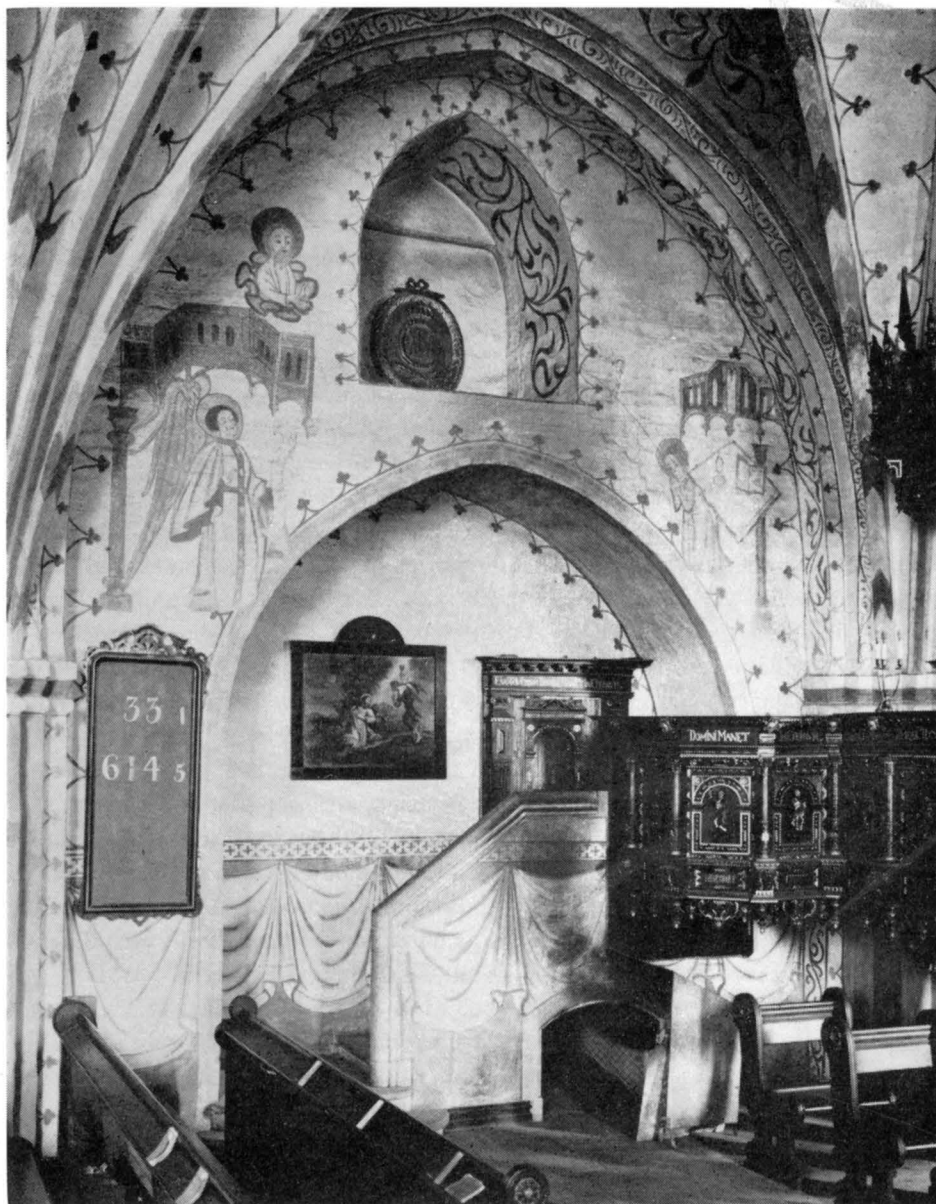
Fig. 281. Ingången från långhuset till sakristian från S, före restaureringen 1944—45. S. 338 och 372.
