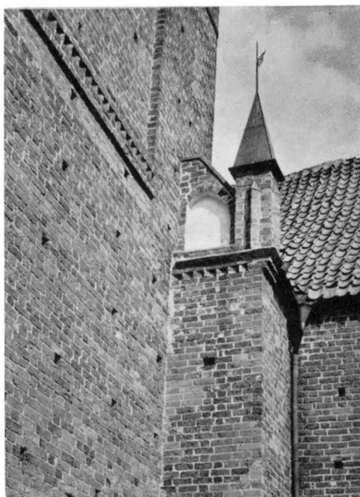
Fig. 266. Detalj av långhusets V-gavel. Foto 1960. S. 334.
