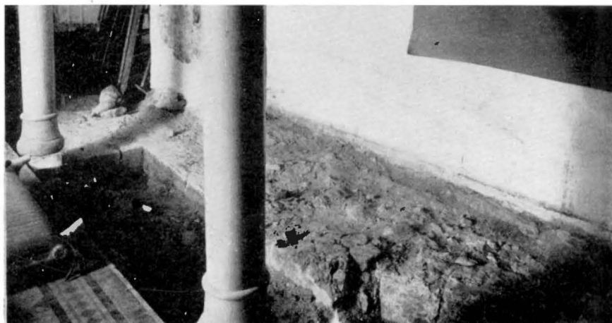
Fig. 46. Bottenskift av sandstenskvadrar till S muren av ett romanskt västtorn. Foto 1934. Untere Schicht von Sandsteinquadern für die S Mauer eines romanischen W Turms. Bottom course of sandstone ashlars in S wall of a Romanesque W tower.
