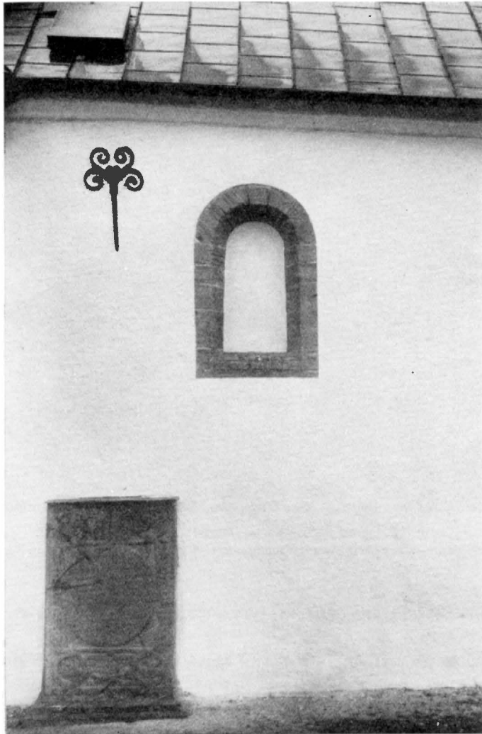
Fig. 23. Romanskt fönster å N fasaden vid c å fig. 17. Ytternischen återupptagen 1961. Foto 1961.
