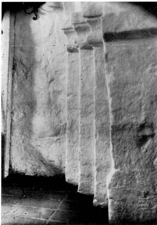
Fig. 179. Detalj från tornrummet, visande bl. a. den urspr. romanska kyrkans V-mur med skråkantsockel (nederst t. h.). Foto 1960.
