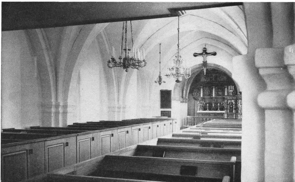
Fig. 132. Interiör mot Ö. Foto 1960. Kircheninneres gegen O. Interior looking E.
