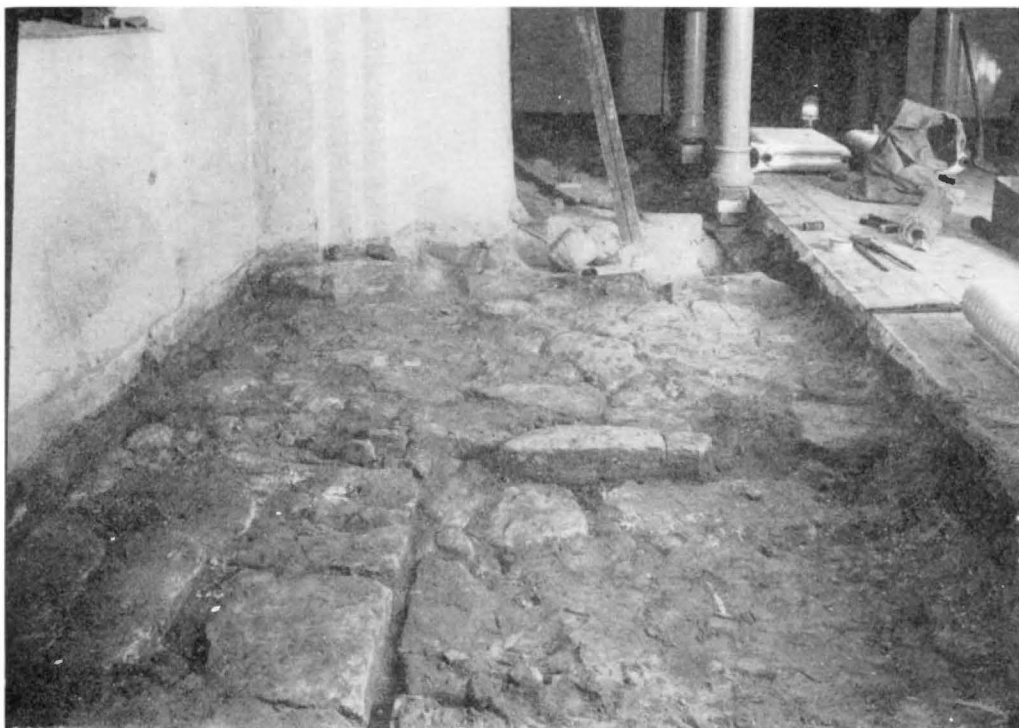
Fig. 30. Medeltida golvläggning eller golvgrund av sandstensplattor i V delen av långhuset. Foto 1934. Mittelalterlicher Fussbodenbelag oder -untergrund aus Sandsteinplatten im W Teil des Langhauses. Medieval flooring or underfloor of sandstone flags in W part of nave.
