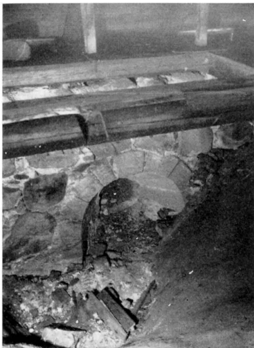
Fig. 129. Romanskt fönster av finhuggen sandsten i S långhusmuren. Foto 1960.
