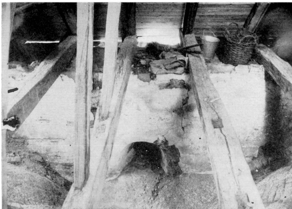
Fig. 19. Romanskt fönster i S långhusmuren (vid a å fig. 17). Foto 1935.
