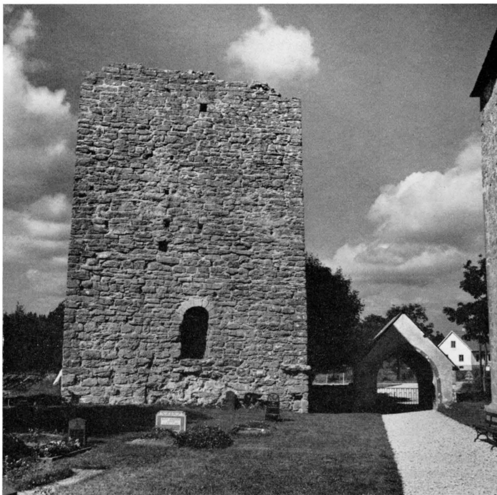
Fig. 759. Kastalen och stigluckan från Ö. Foto 1960.
