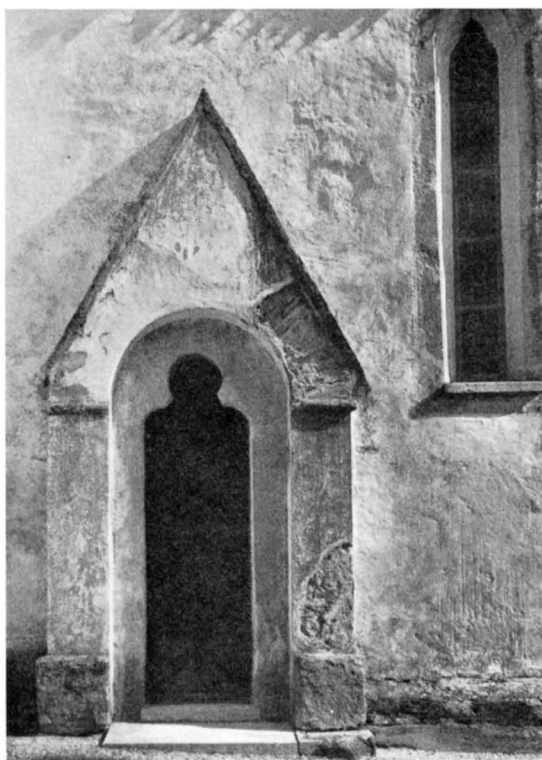
Fig. 713. Korportalen och korets S fönster. Foto 1960. Das Chorportal und das S Chorfenster. Chancel portal and S window of chancel.
