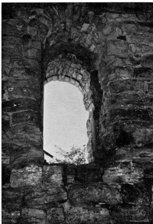
Fig. 760. Kastalens ursprungliga Ö portal sedd inifrån. Foto 1960.
