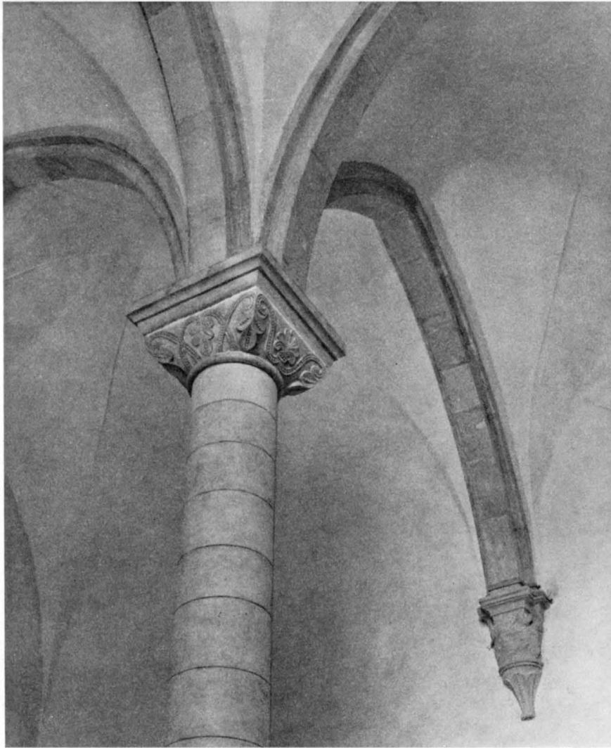
Fig. 792. Kolonn och valvbågar i långhuset. Foto S. Hallgren 1959. Pfeiler und Gewölbebogen im Langhaus. Column and arches in nave.
