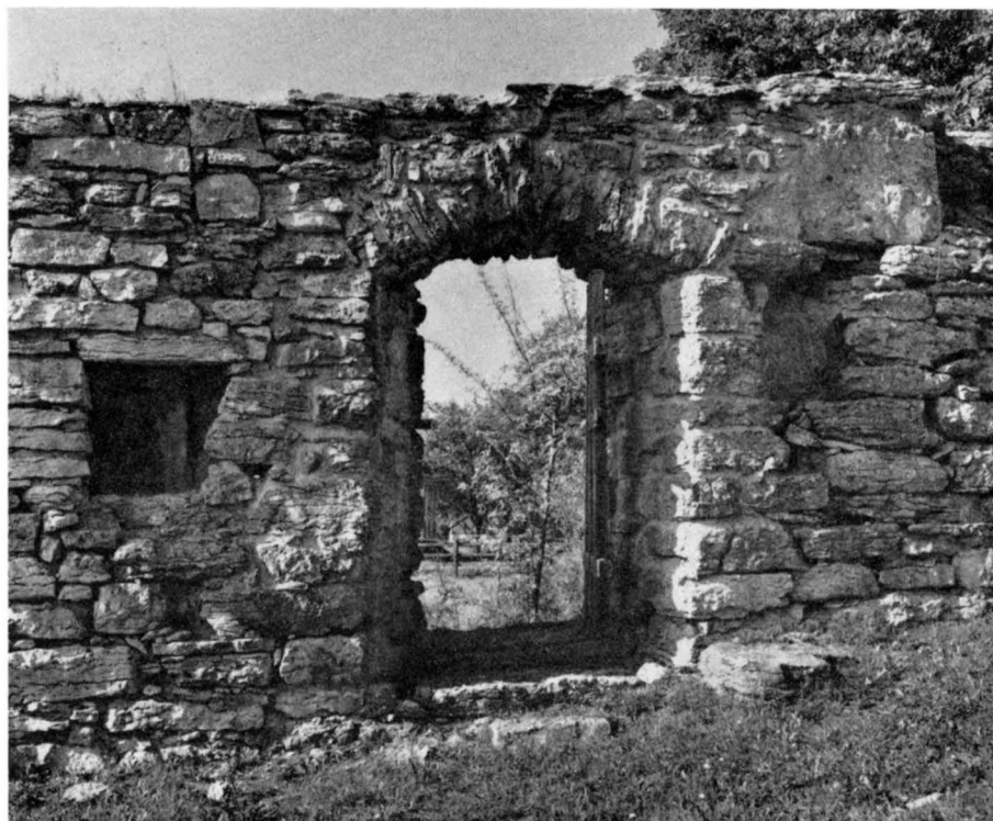
Fig. 917. Portal och nischer i korets N mur. Foto 1960. Portal und Nischen in der N Mauer des Chors. Doorway and niches in N wall of chancel.
