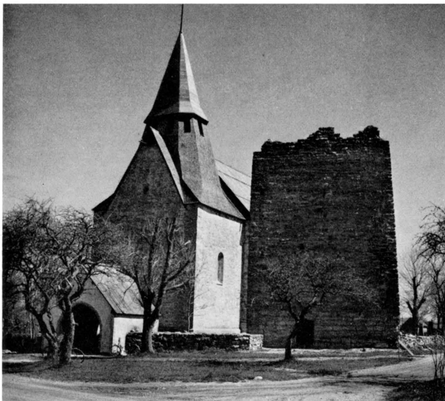
Fig. 754. Kyrkan och kastalen från SV. Foto G. Svahnström 1958. Die Kirche und der Kastal-Turm von SW. The church and citadel from SW.
