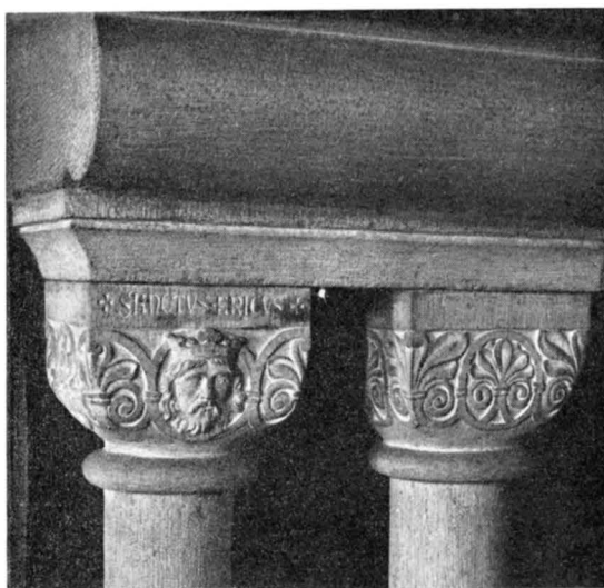
Fig. 869. Kolonnetter och kapital vid tornbågens N vederlag, från restaureringen 1900—1902. Foto 1960. Säulchen und Kapitele am N Kämpfer des Turmbogens von der Restaurierung 1900—02. Colonnettes and capital at N abutment of tower arch, from the restoration 1900—02.
