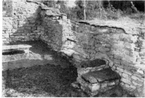
Fig. 911. Ruinens inre mot SO. Foto S. Hammarlund 1948.
