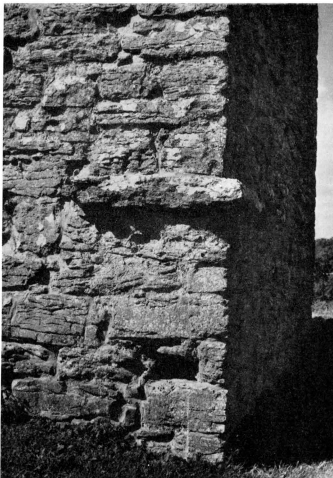
Fig. 761. Överliggare, anslagsstenar och bomhål vid kastalens NÖ hörn. Foto 1960.
