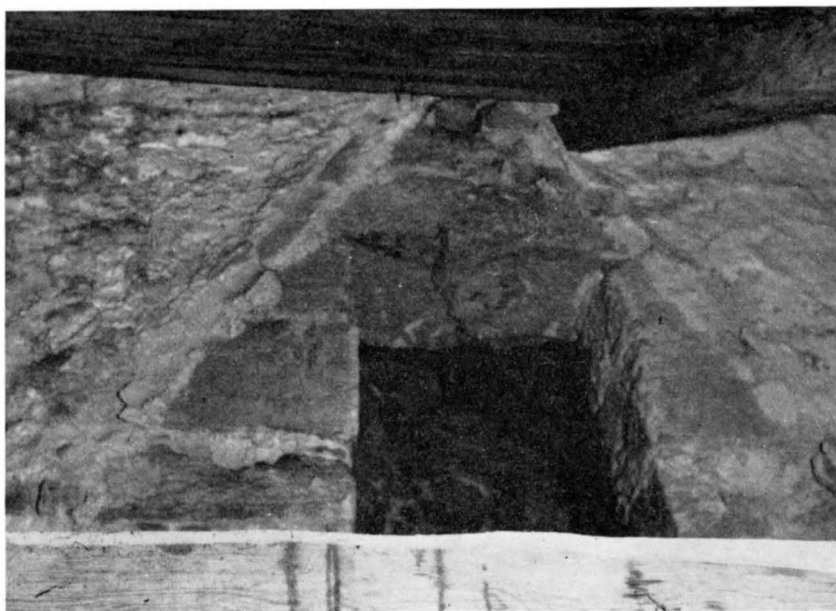
Fig. 776. Korets N yttermur från sakristians vind. Sakristians ursprungliga röste tydligt skönjbart. Foto 1960.
